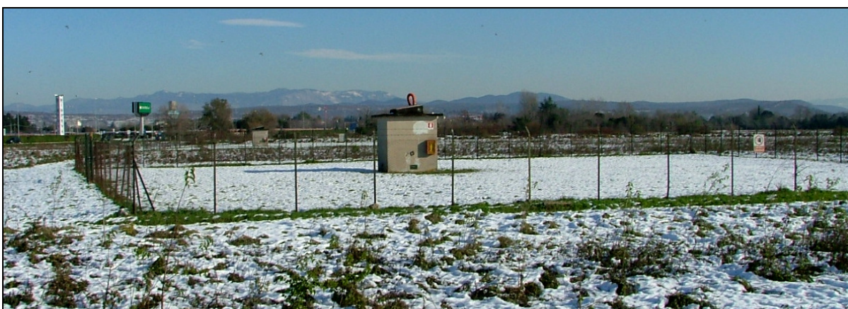
Area recintata con all'interno la struttura del pozzo di captazione idrica
