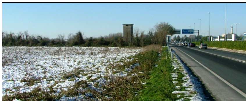
SS n° 14 nei pressi dell'ingresso all'aeroporto di Ronchi dei Legionari
