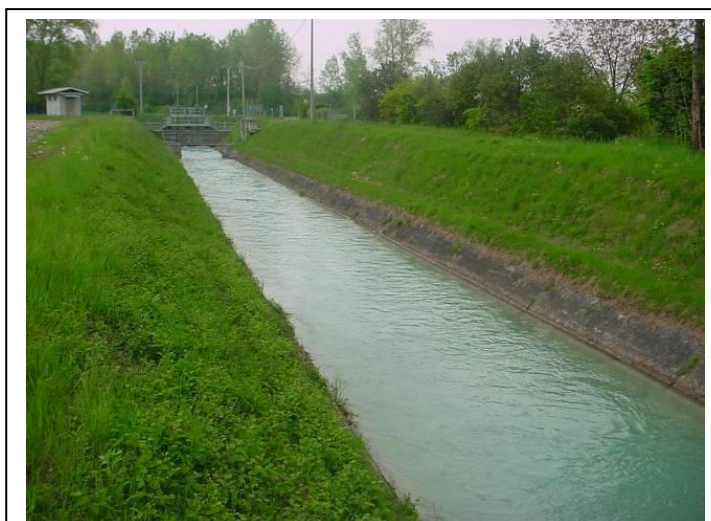
Figura 120 - Consorzio di bonifica Cellina Meduna: canale principale di Villa Rinaldi che alimenta i comizi irrigui a scorrimento nella zona nord di Pordenone compresa tra l'abitato di Cordenons e Fontanafredda
