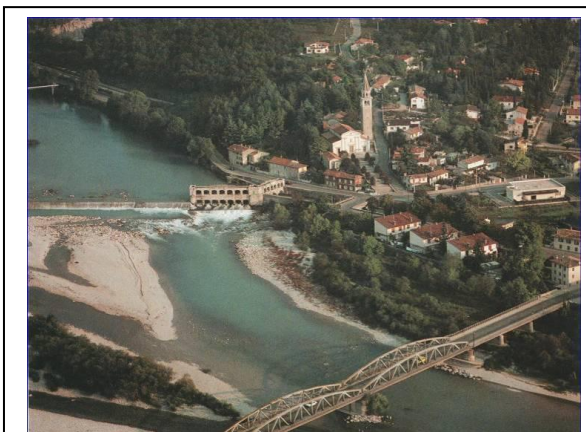
Figura 130 - Derivazione a usi irrigui e idroelettrici in comune di Sagrado
