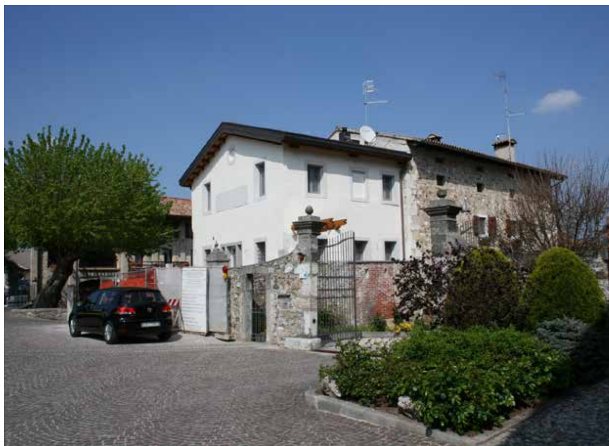
Scorcio all'interno del borgo. In primo piano l'ex scuola merletti – IMG_1496
