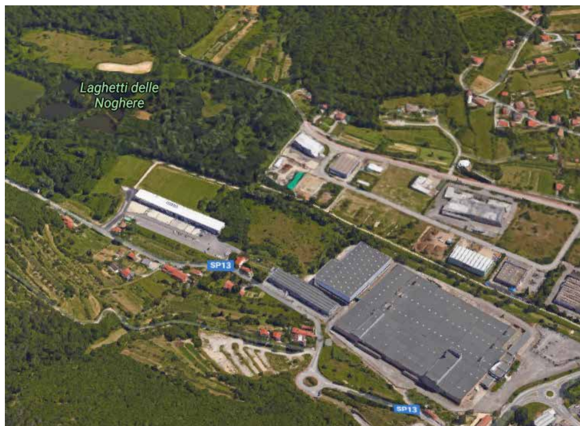
La parte meridionale dell'ambito tutelato coincide in gran parte con il biotopo dei Laghetti delle Noghere; il settore settentrionale dell'area tutelata è invece segnato dalla presenza invasiva di un capannone artigianale
