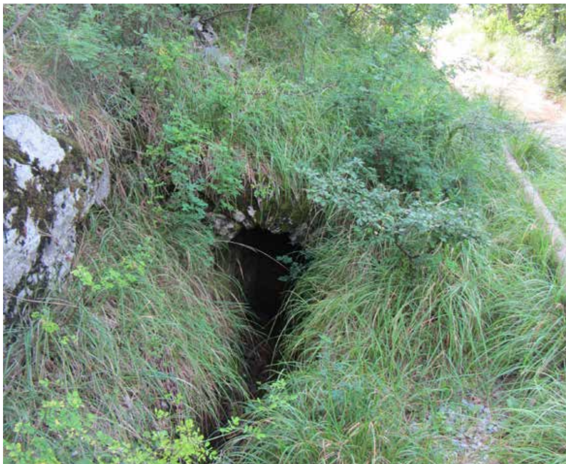
11. L'acquedotto ricoperto da fitta vegetazione spontanea.
