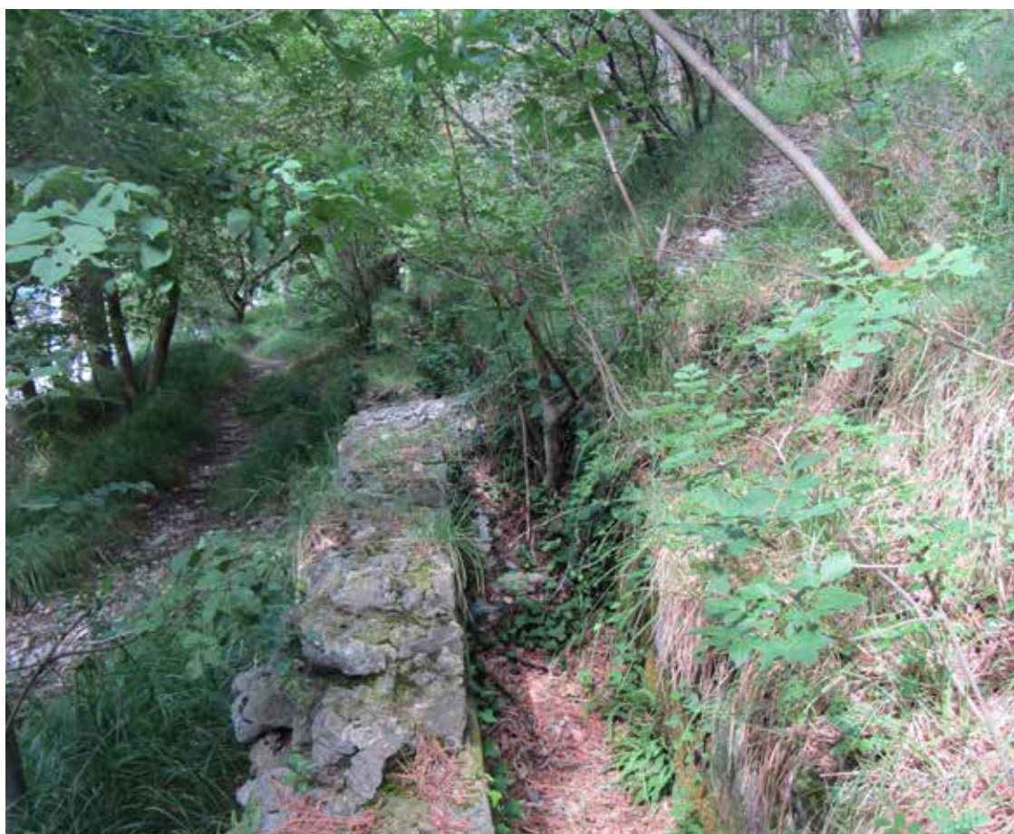
9. La struttura dell'acquedotto ricoperta da vegetazione spontanea.
