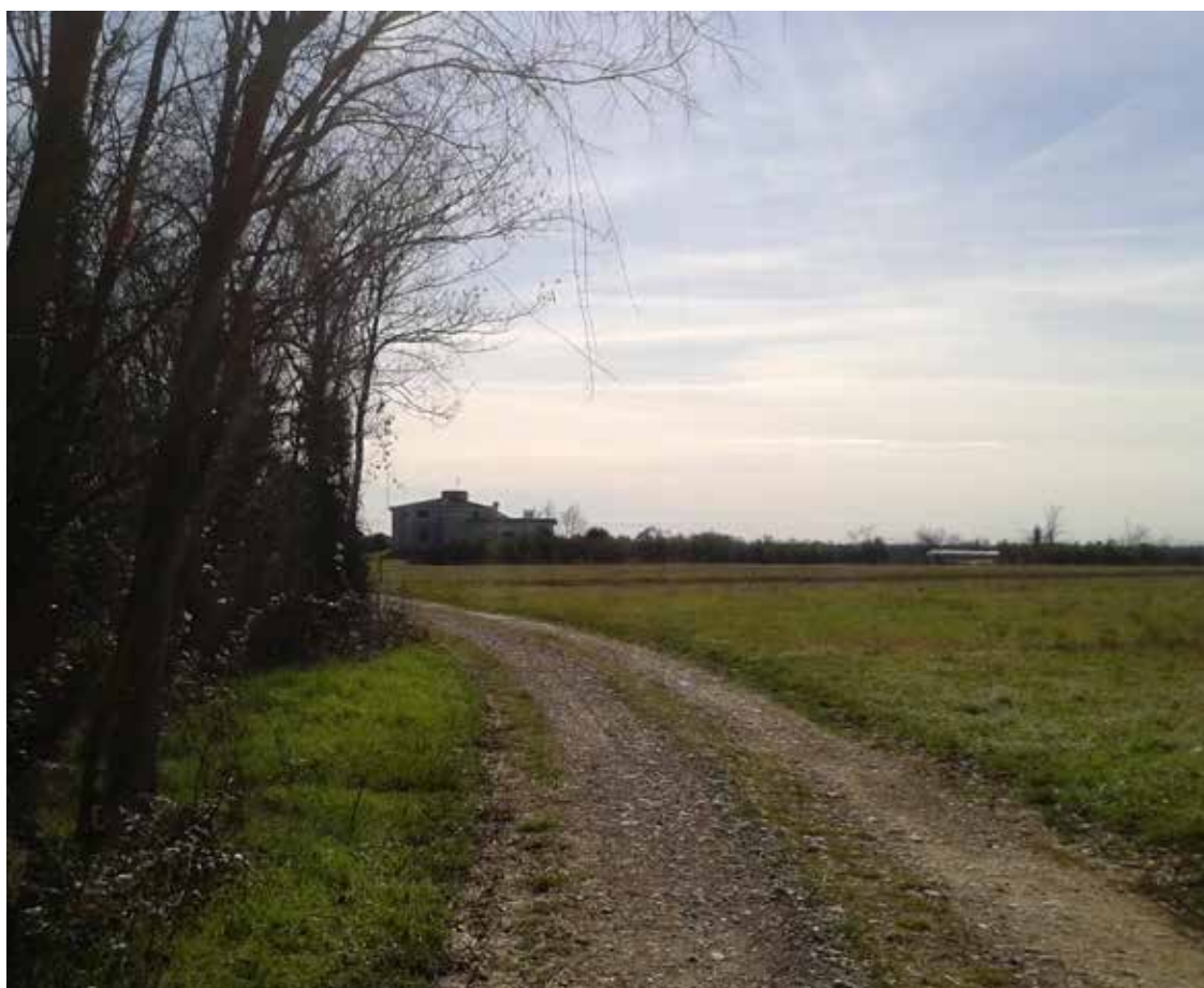
6. L'edificio privato che occupa la parte più meridionale del terrazzo.
