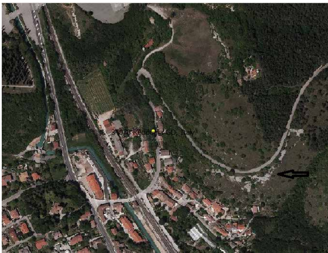
2. Le macerie della cinta piú esterna del Castelliere di Redipuglia sono visibili a sud della grande curva della strada asfaltata che porta alla sommità del Sacrario.
