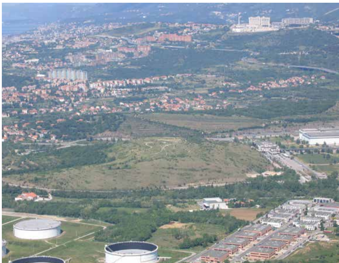
1. La vallata attraversata dal torrente Rosandra con al centro i due rilievi del Monte Usello e del Monte San Rocca tra i quali oggi corre il raccordo autostradale.
