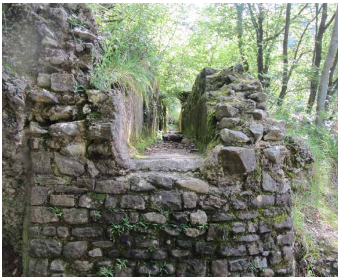
6. Particolare della struttura del canale.
