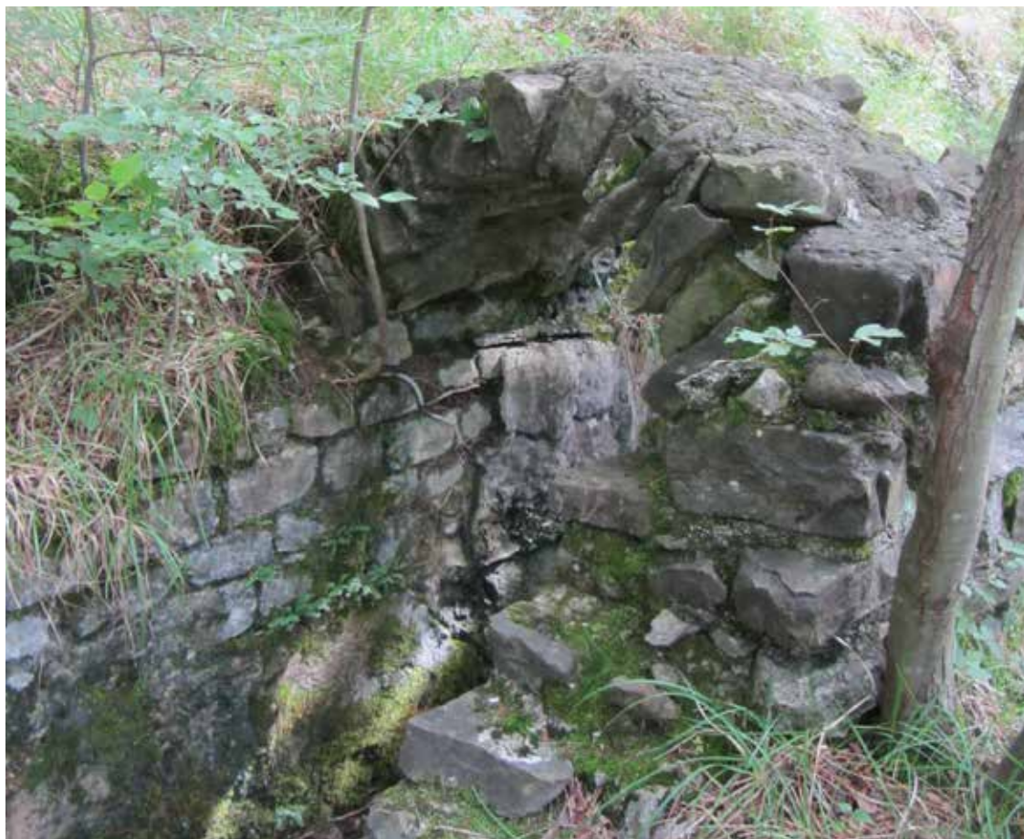
4. Particolare della volta dell'infrastruttura idrica.
