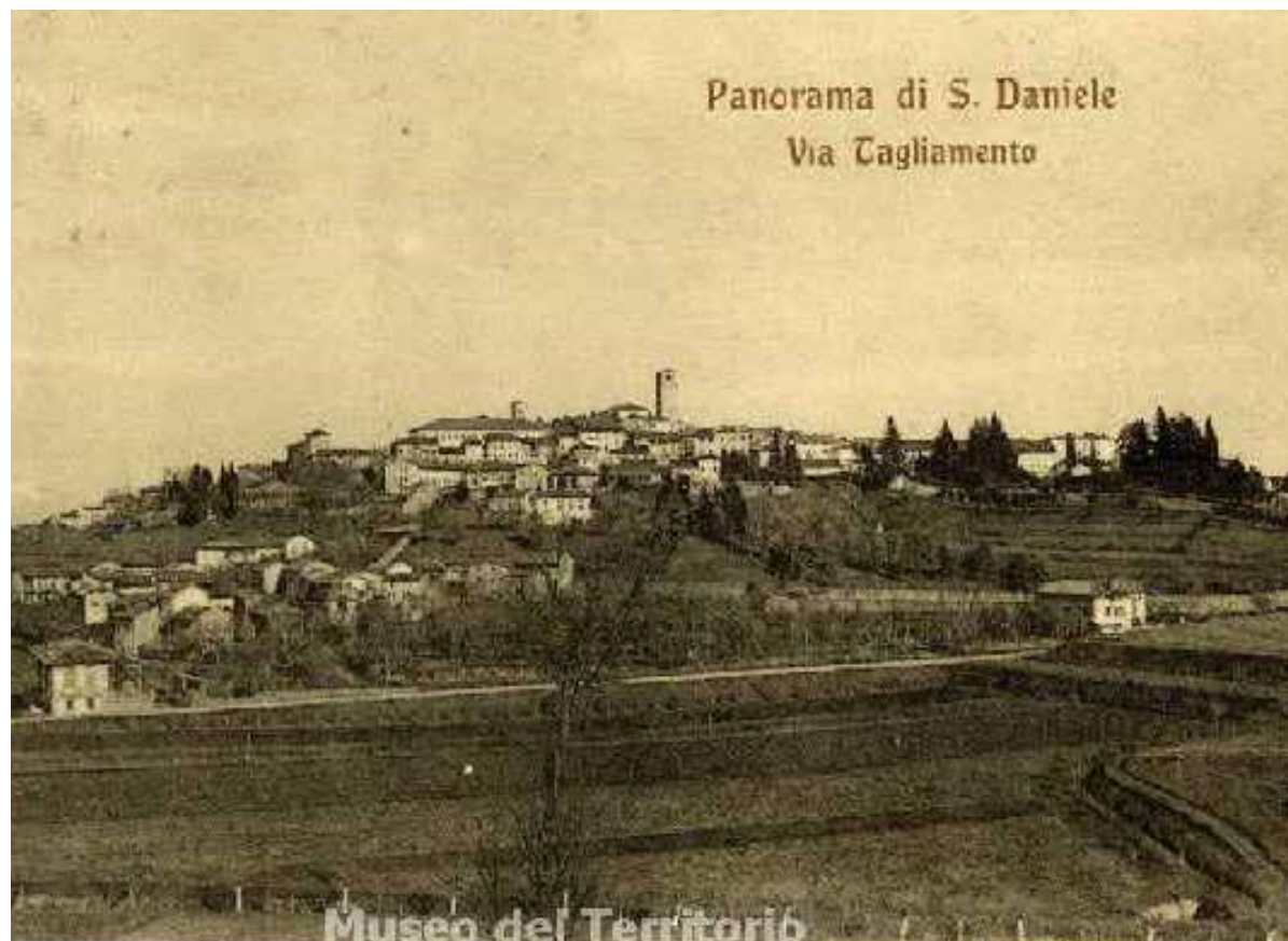
Rilievo fotografico del 1910
