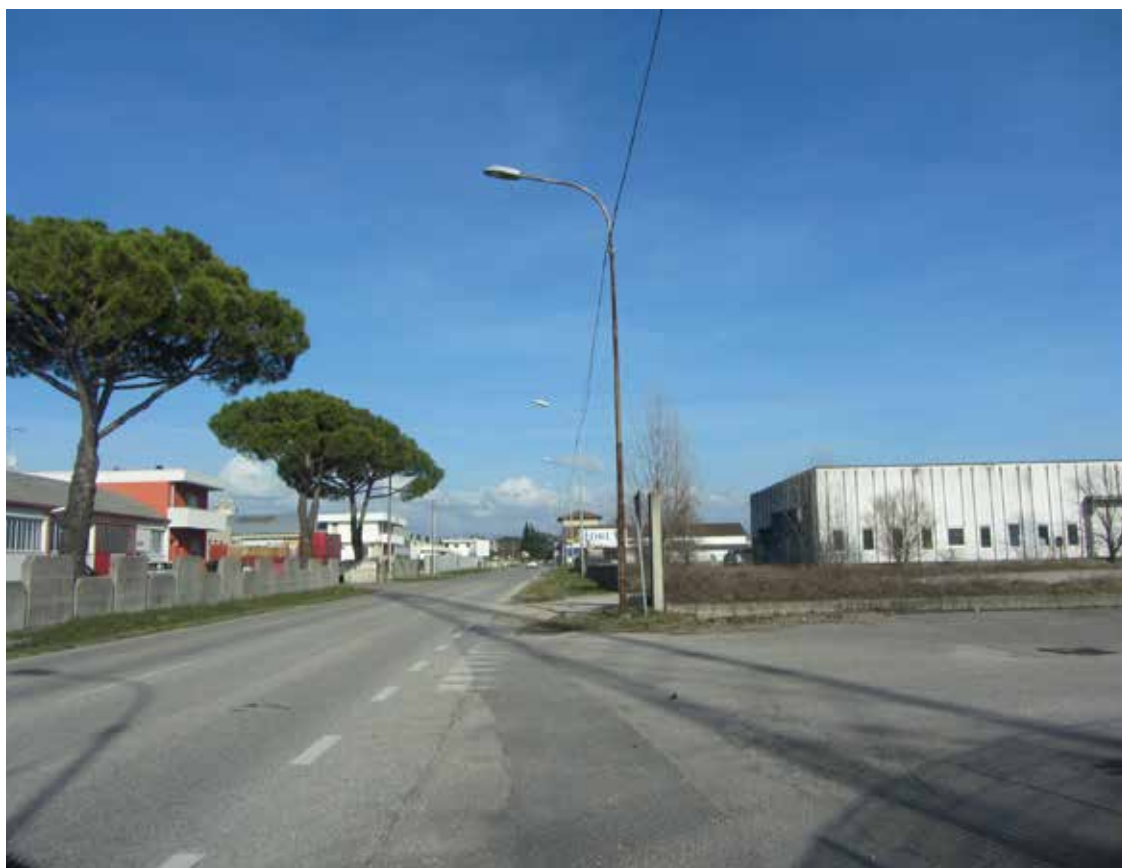
10. Via del Cristo nella zona industriale di Manzano perpetua il decumano che delimita a nord la centuria di Soleschiano (da ovest verso est).
