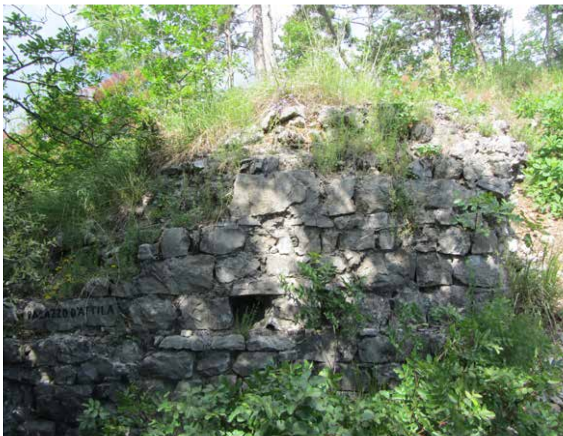
7. Sostruzioni della villa di età romana che si affacciava sull'insenatura di Boccadino.
