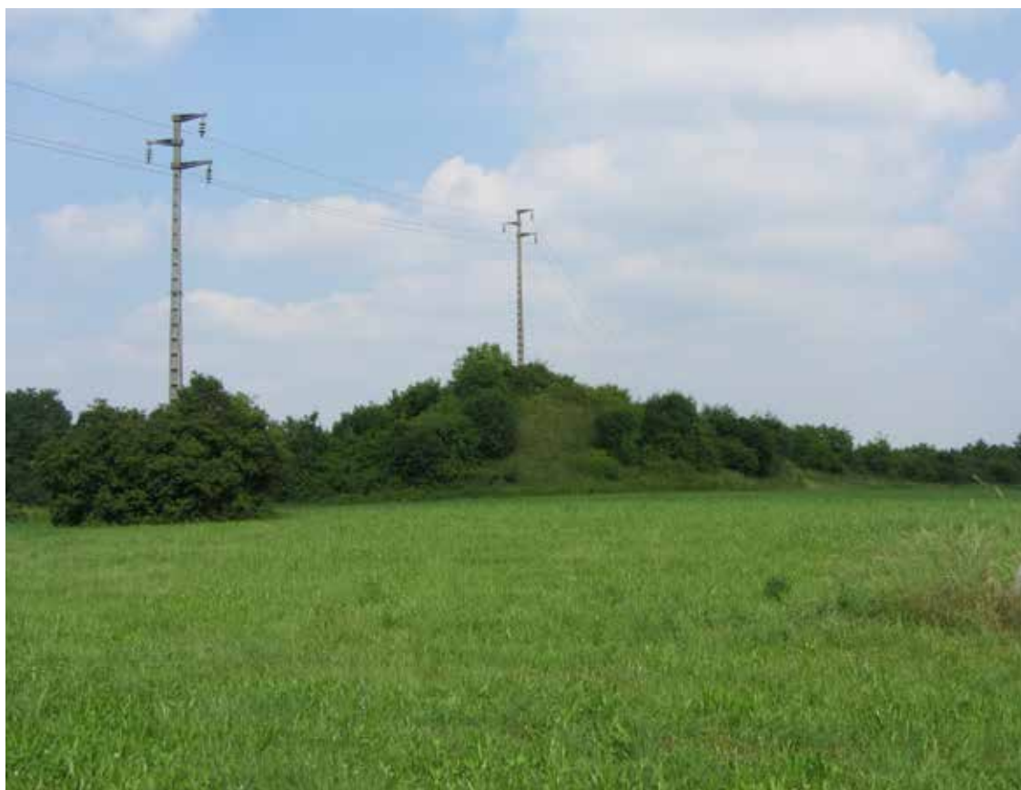
9. Il terrapieno settentrionale in corrispondenza del quale sono stati impiantati tralicci dell'alta tensione.
