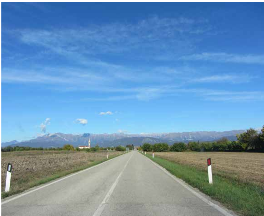
2. Sebbene deformata, la strada Rizzolo-San Bernardo riprende l'orientamento di un cardine.
