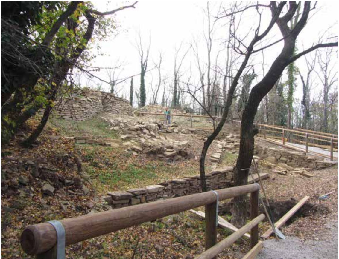
9. La sistemazione della sommità del Monte dopo le campagne di scavo e il conseguente allestimento di un percorso archeologico-naturalistico da parte del Comune di Muggia.
