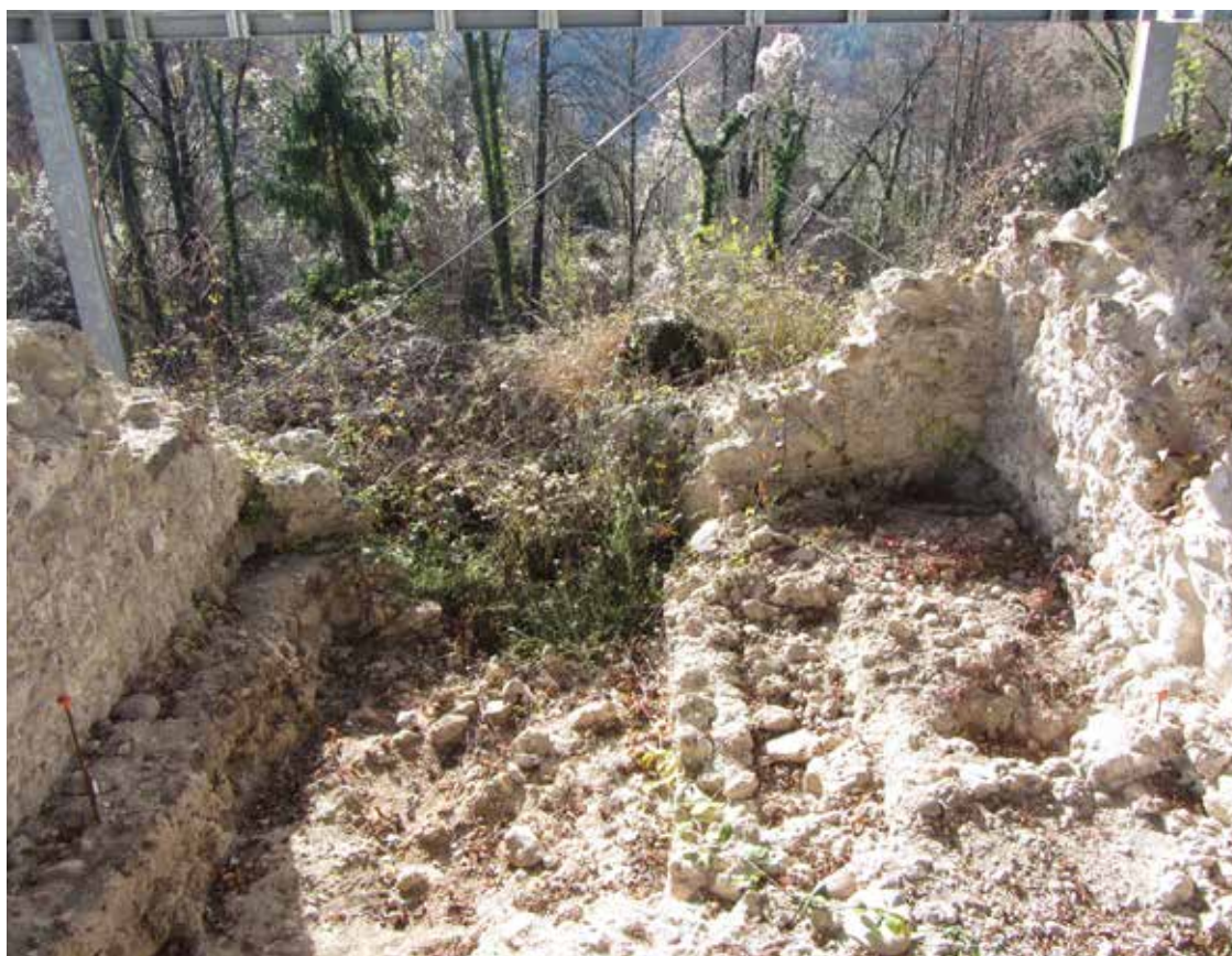
5. I resti della torre visibili sotto la copertura.
