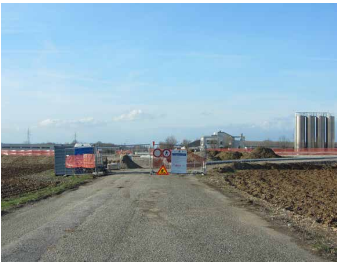
4. San Lorenzo: i lavori per l'inserzione di una rotonda in corrispondenza della strada che perpetua il limite est della centuria.
