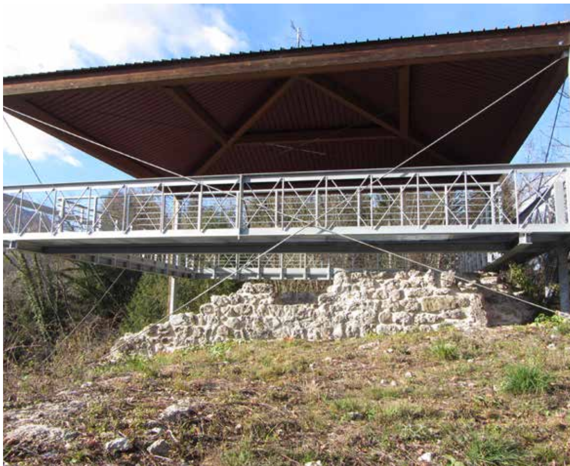
4. La copertura della torre realizzata in anni recenti.
