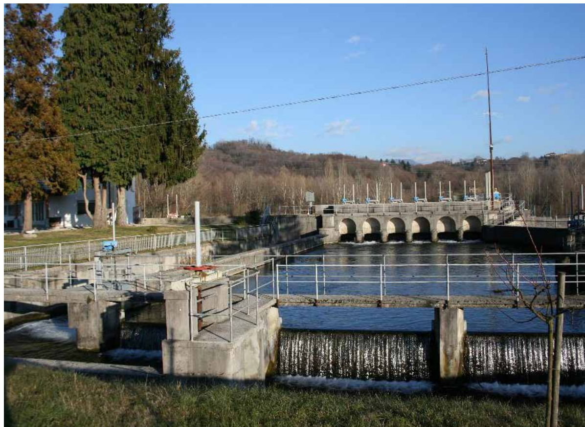
Opere di presa a Zompitta - IMG_8547
