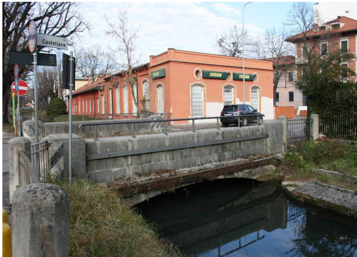
Attraversamento canale Ledra in viale Ledra – IMG_0841
