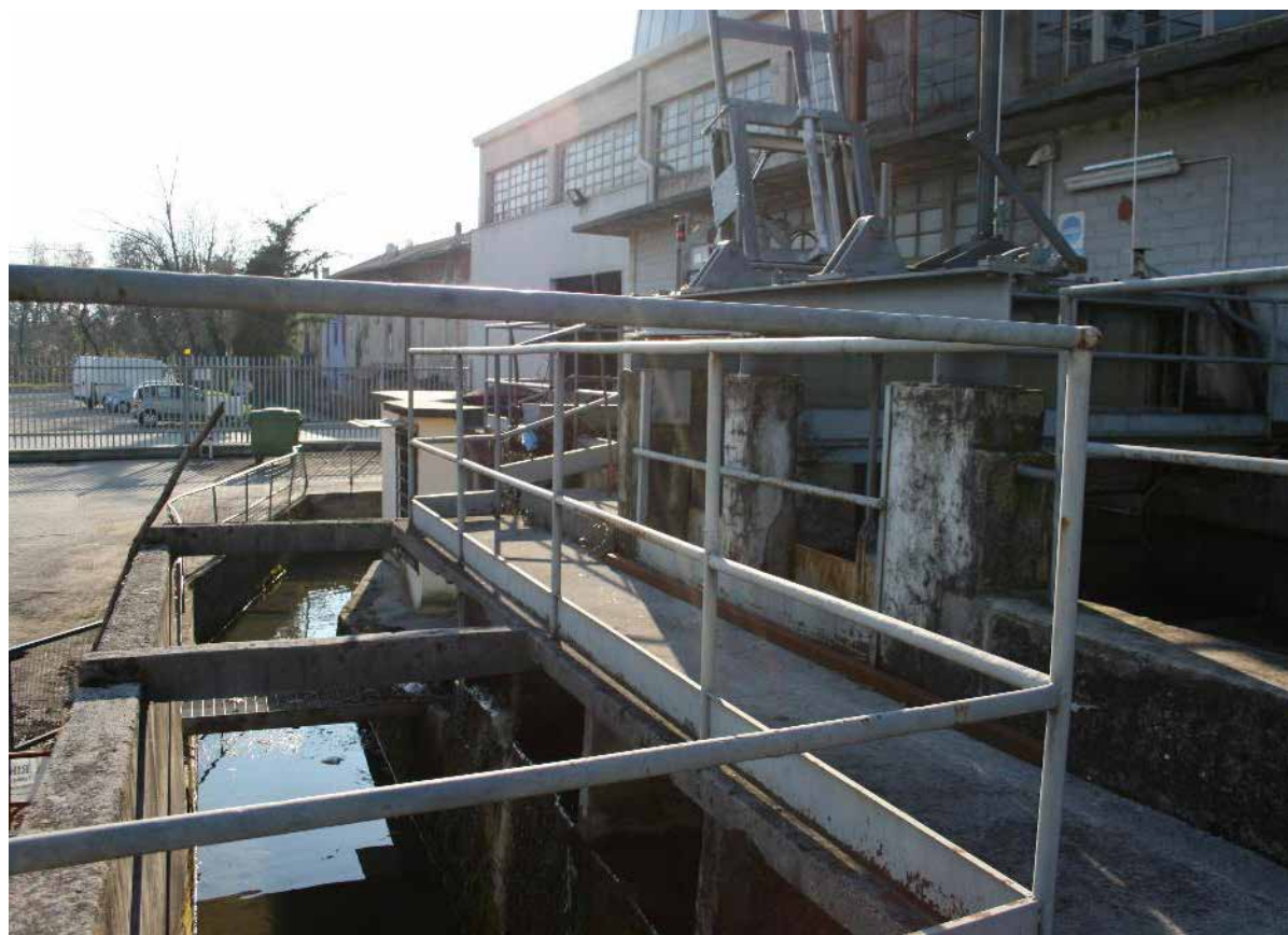
Opere di derivazione a Molin Nuovo presso la Nuova Siderurgca, lungo la roggia di Udine – IMG_9015
