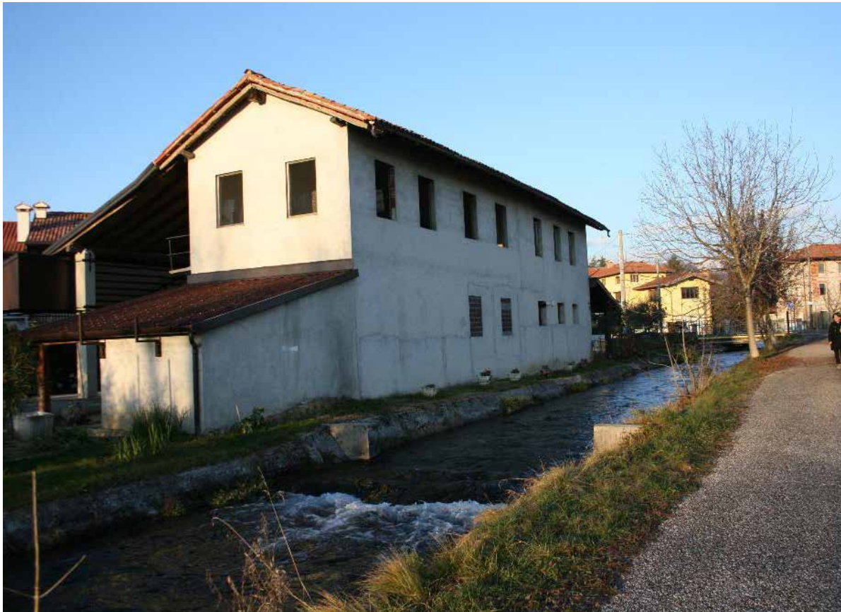
Sponde basse in cemento a sud di Zompita - IMG_8613
