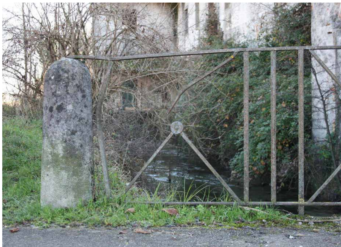
Antico parapetto in ferro a San Bernardo, lungo la Roggia di Palma - IMG_8846
