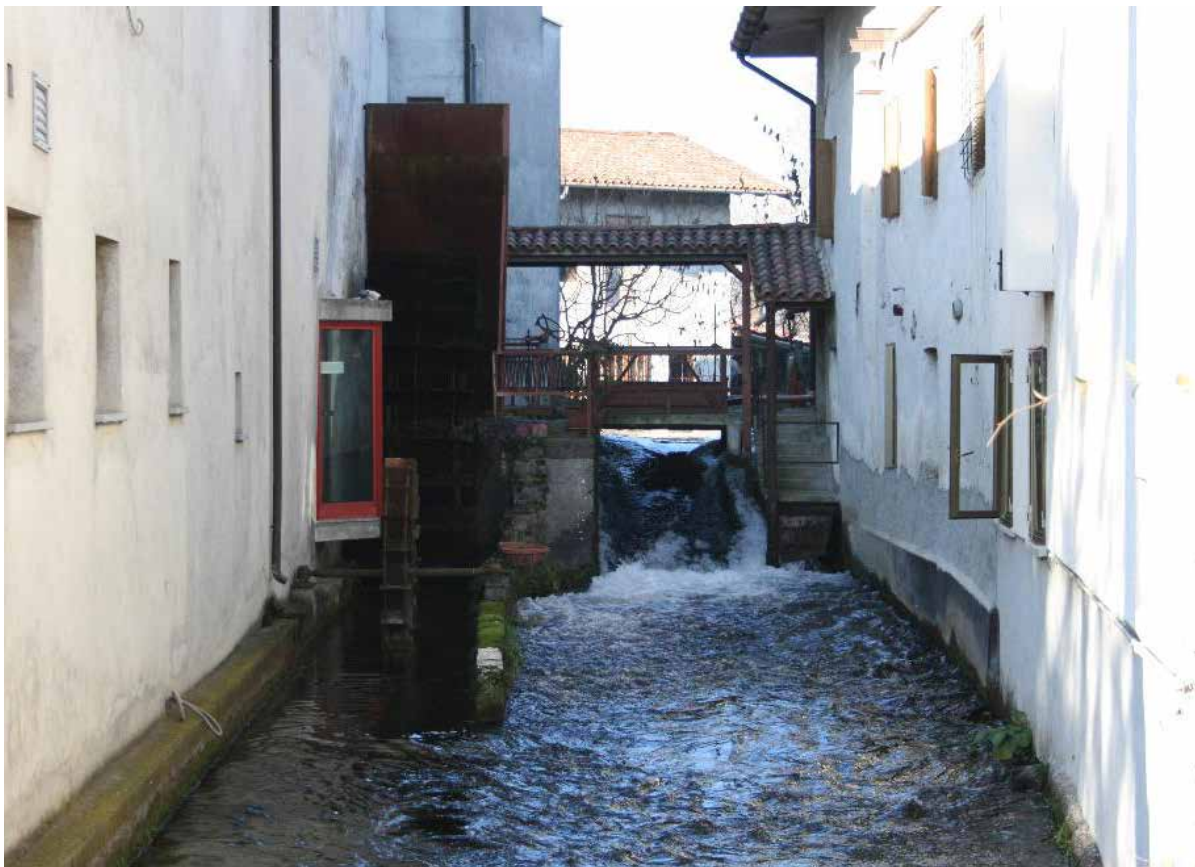
Opificio a Borgo Comelli con i meccanismi idraulici e il salto d'acqua sulla Roggia di Udine – IMG_8675
