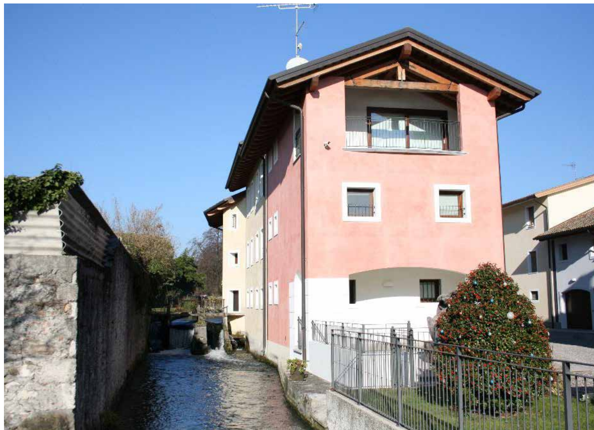
Opere di derivazione a Cavalicco lungo la roggia di Udine – IMG8982
