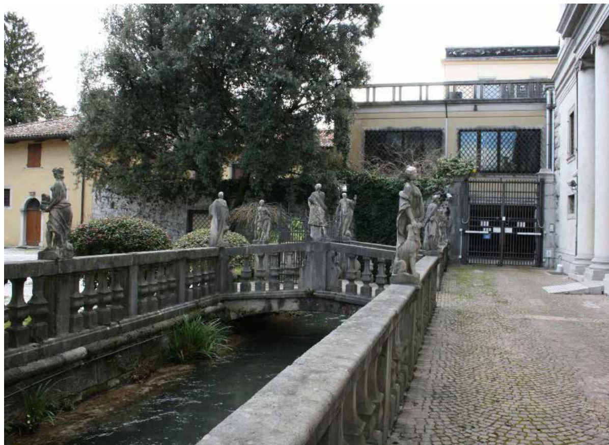
Ponte di attraversamento della roggia di Udine nel giardino di Palazzo Antonini – IMG_0264
