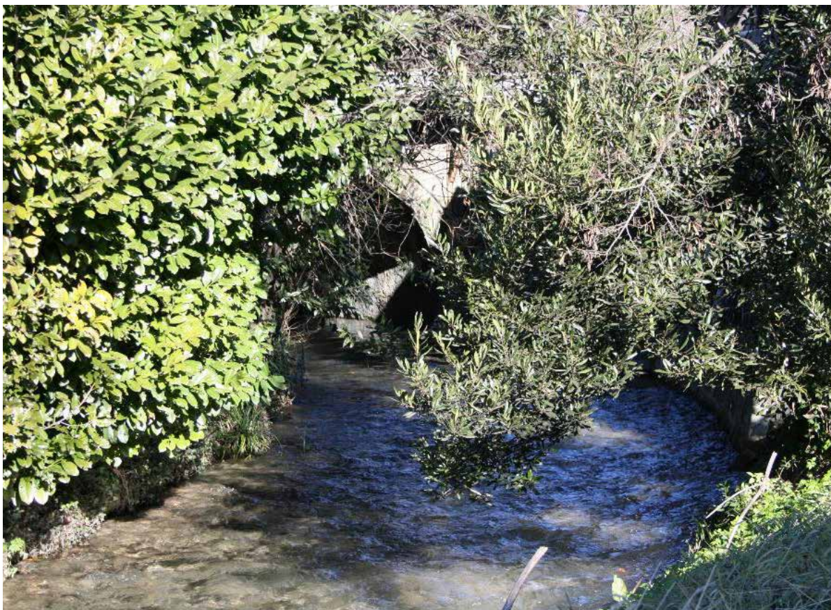
Sullo sfondo l'attraversamento della linea ferroviaria lungo la roggia di Udine – IMG 0675
