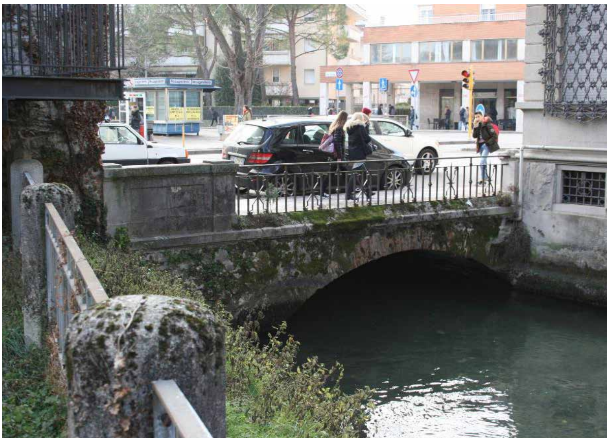
Attraversamento Canale Leda in piazzale Cavedalis davanti alla torre – IMG_0827
