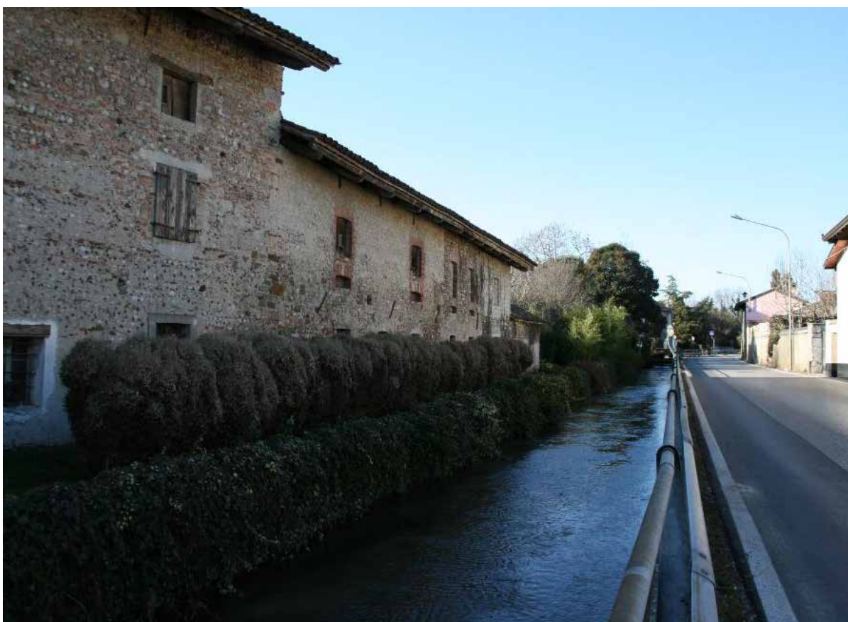
Edificio rurale a Risano lungo la roggia di Palma - IMG_0401
