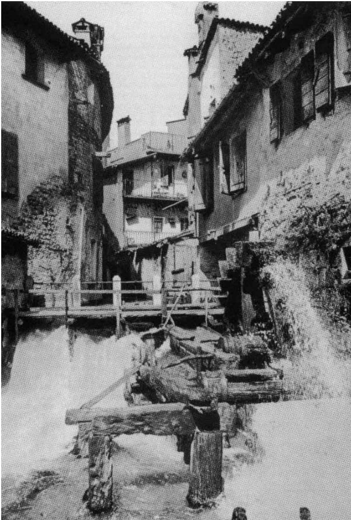
img 196 (Mulino in via del Gelso, lungo la roggia di Udine prima della demolizione)
