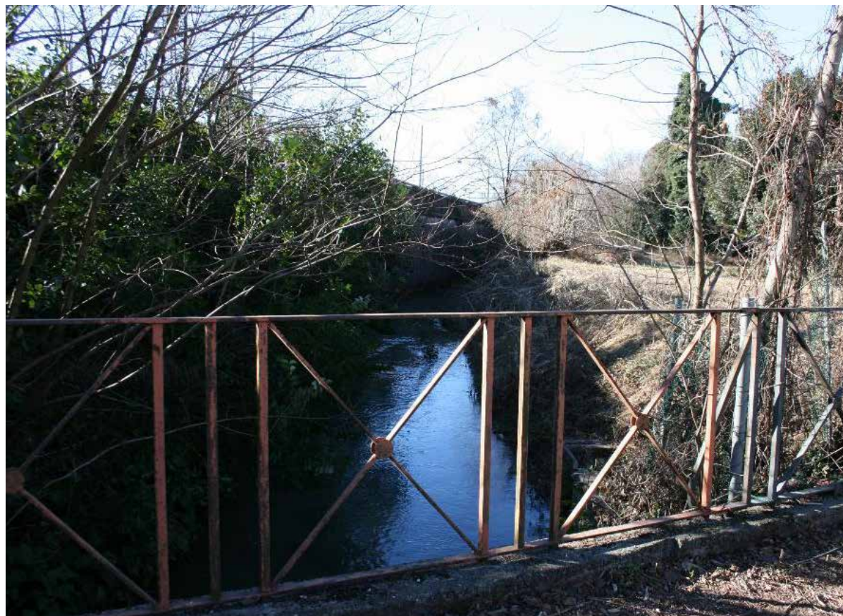
Attraversamento con i caratteristici parapetti in ferro in via della Roggia, lungo la roggia di Udine – IMG 0670
