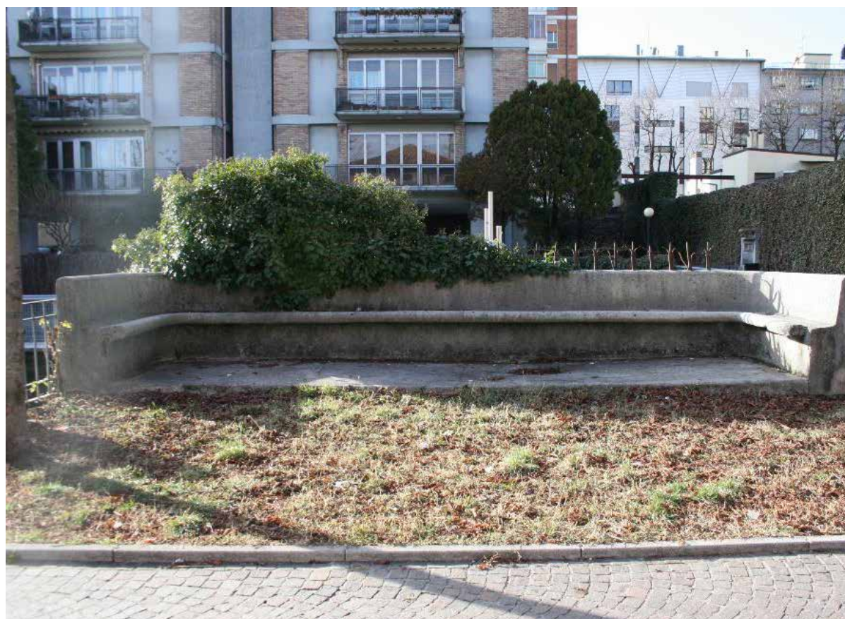
Area di sosta in via Marangoni lungo il Canale Ledra – IMG_0902
