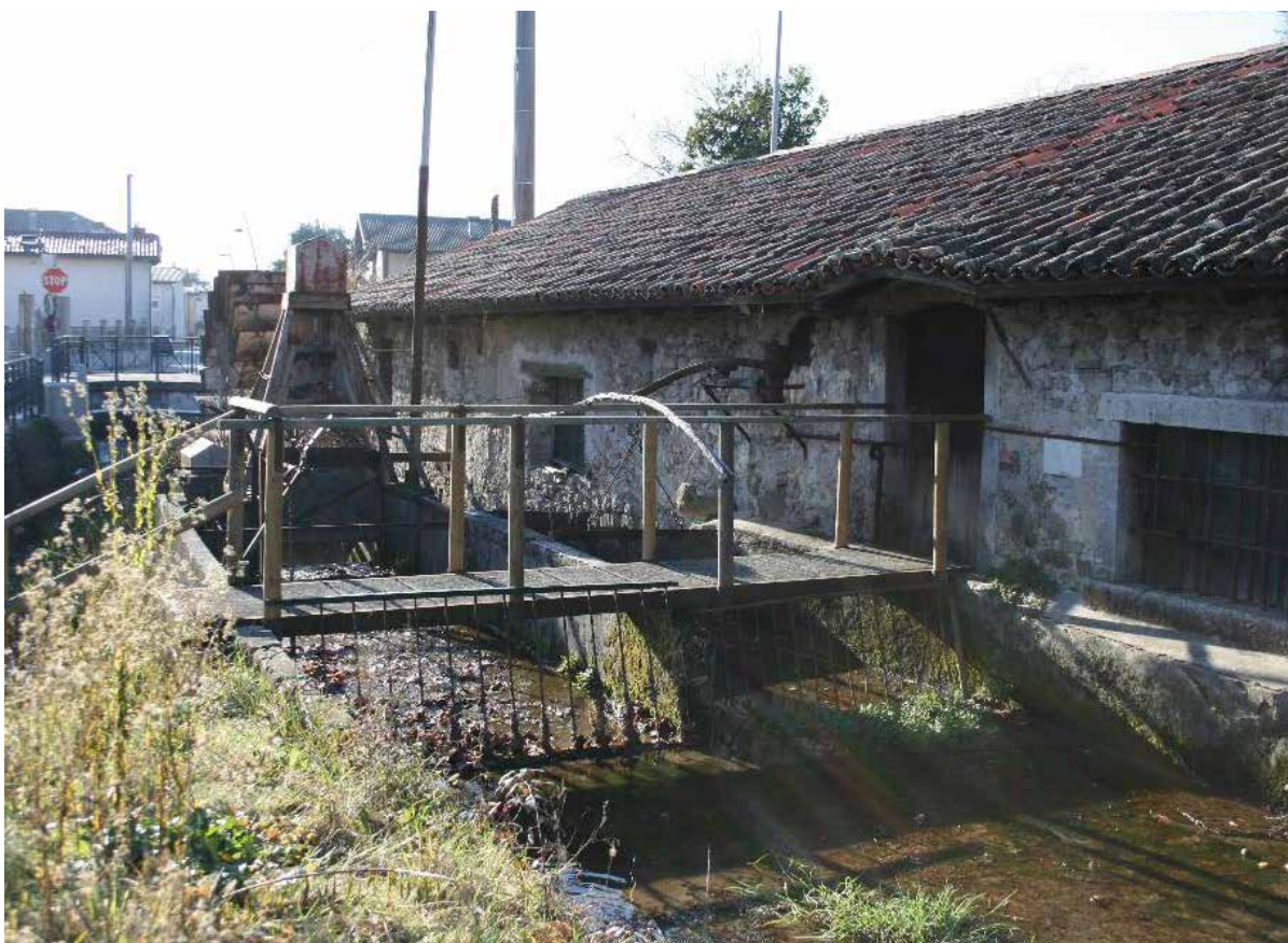
Opificio a Rizzolo con i meccanismi idraulici e il salto d'acqua sulla Roggia di Udine – IMG_8898
