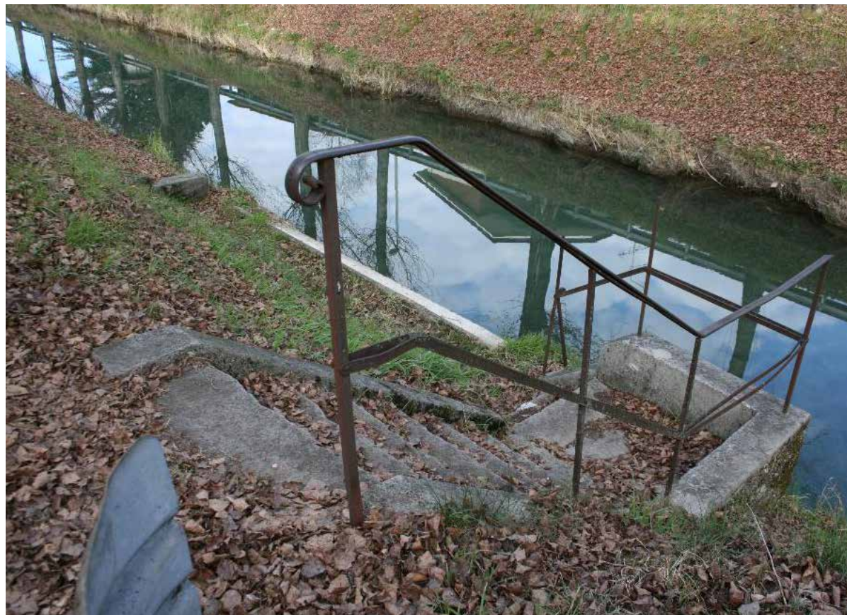
Lavatoio lungo il canale Ledra in via Martignacco – IMG_0803
