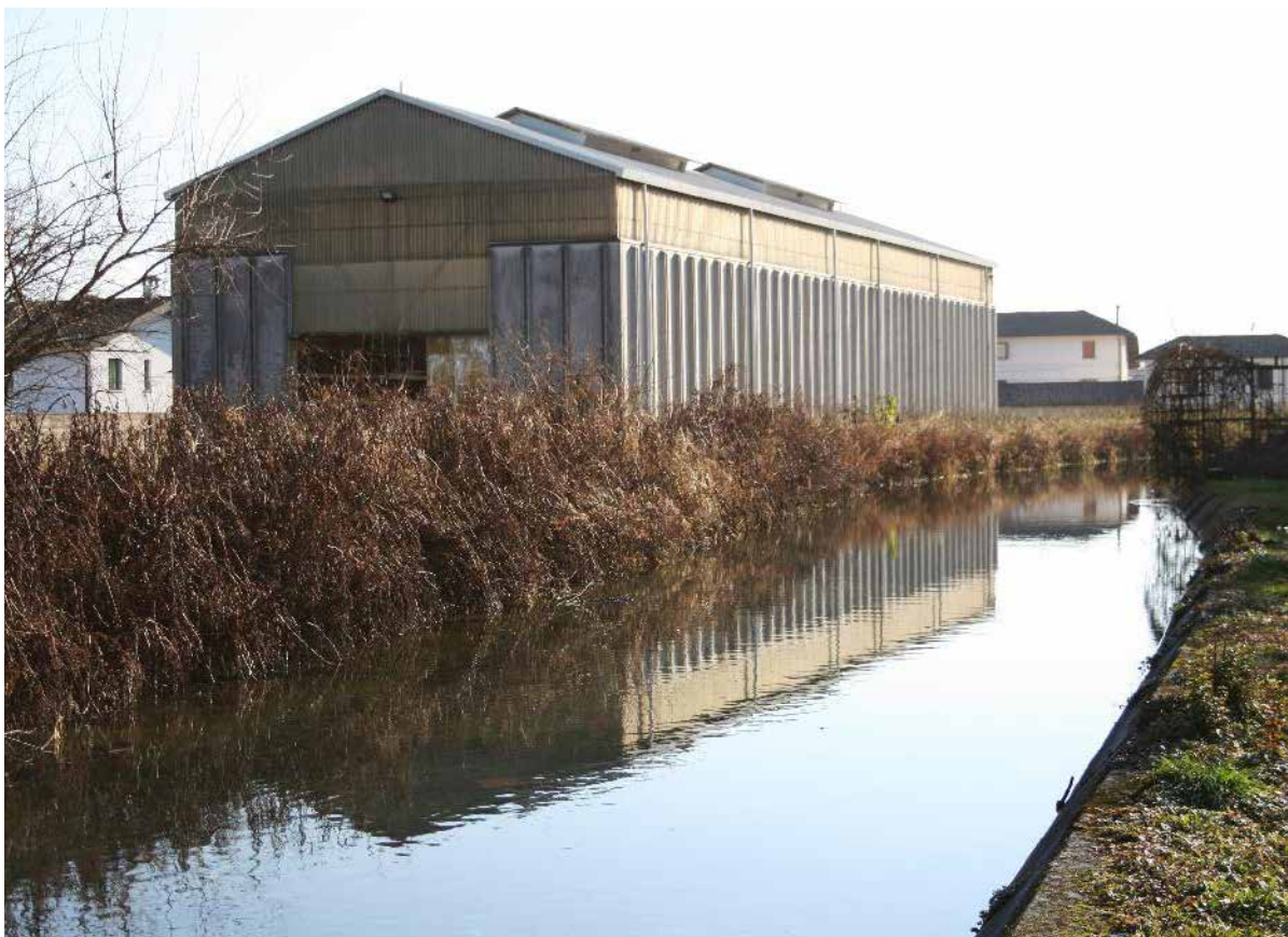
Uno stabilimento della "Nuova Siderurgica di Cavalicco" si specchia nelle acque della roggia di Udine, lungo la pista ciclopedonale – IMG_9007
