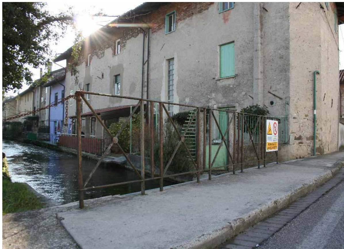
Manufatto di attraversamento con antico parapetto in ferro a Molin Nuovo, lungo la roggia di Udine - IMG_9017
