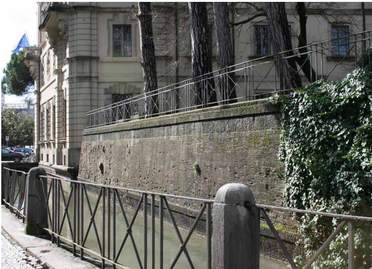
Muro di sostegno del giardino Ricasoli e parapetti sulla roggia di Palma in via Piave . IMG 7740
