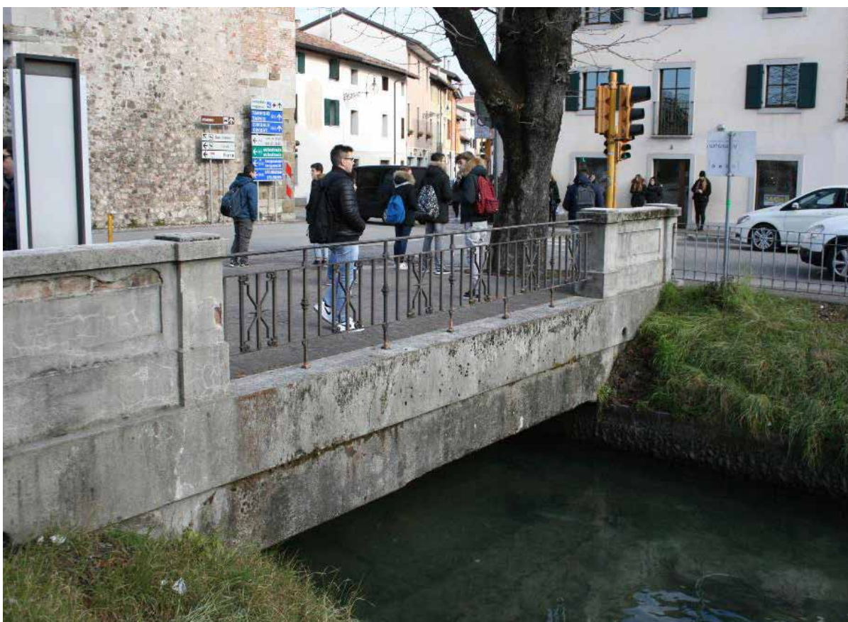
Parapetto attraversamento canale Leda in piazzale Cavedalis – IMG_0830
