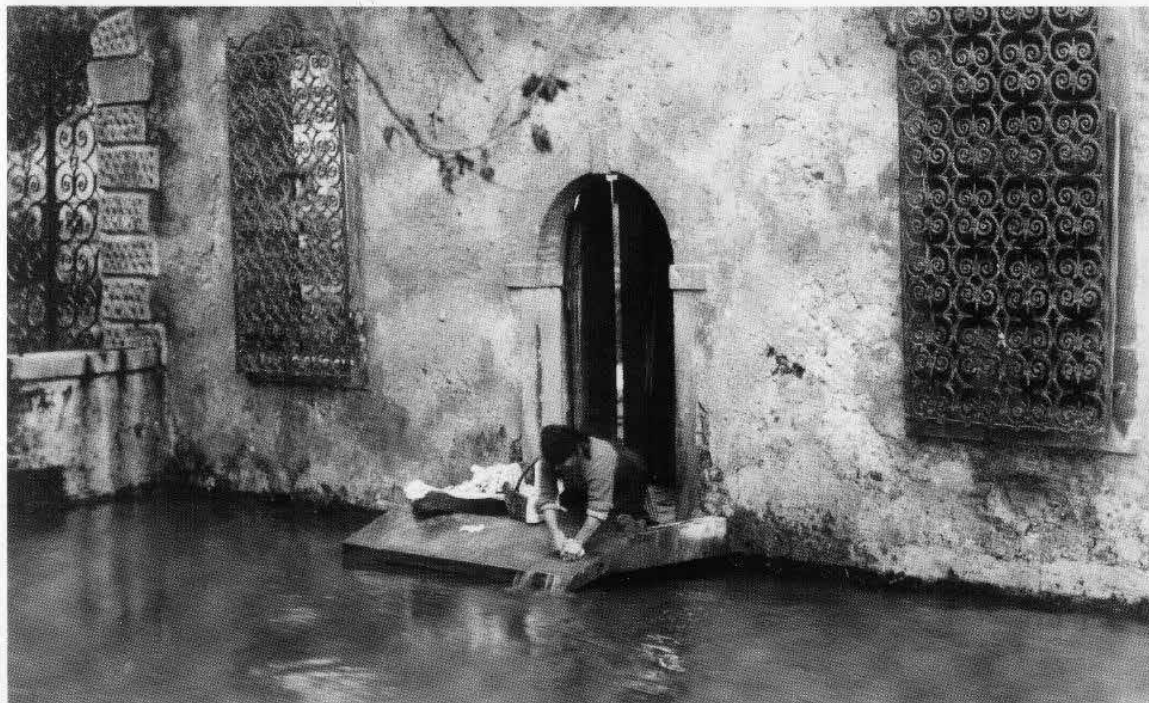
Via Antonio Zanon prima delle modifiche per la costruzione dell'adiacente Galleria del Lavoratore. 1946
