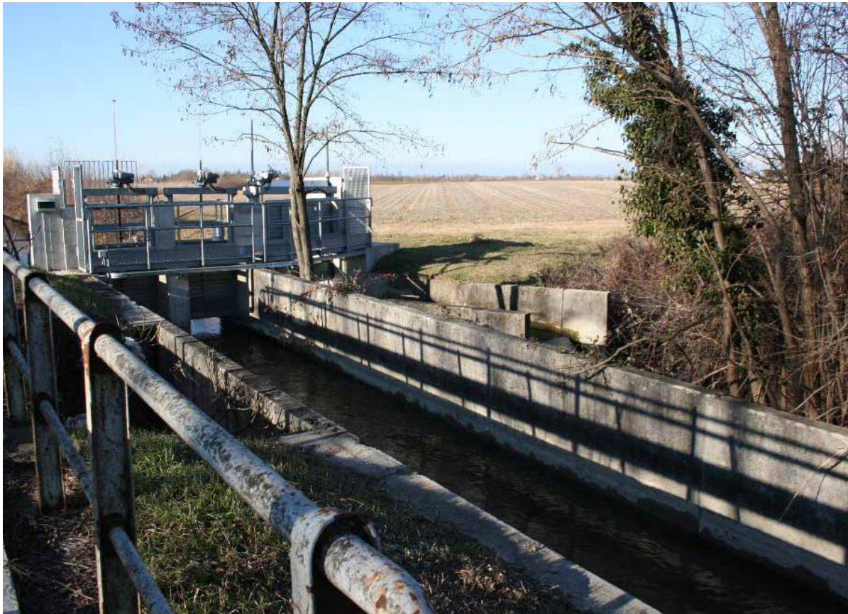
Nodo idraulico: le acque della roggia di Palma in parte si gettano nella roggia Brentana e in parte proseguono per Palmanova – IMG_0511
