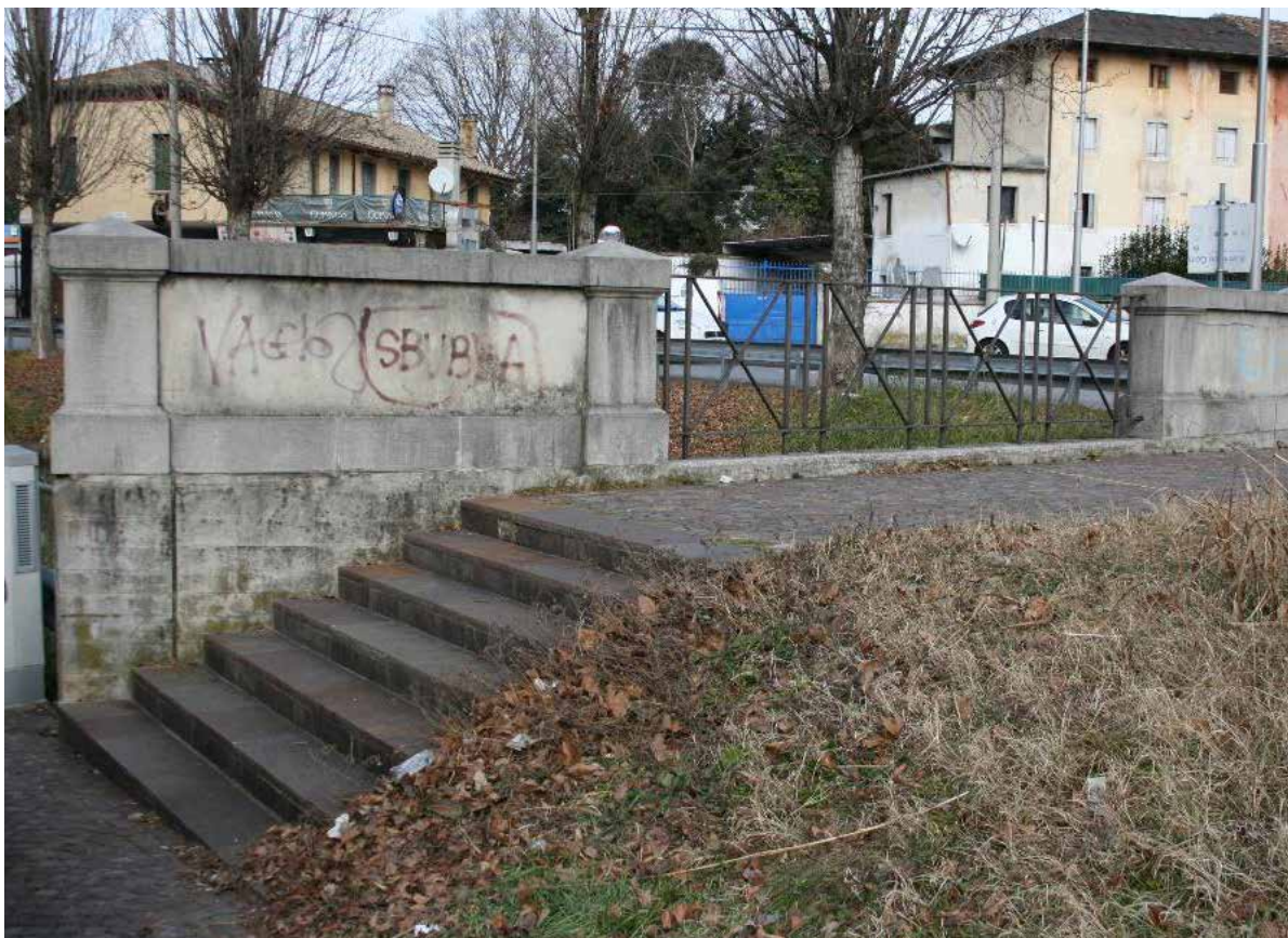
Parapetto attraversamento Canale Ledra in piazzale Diacono – IMG_0806
