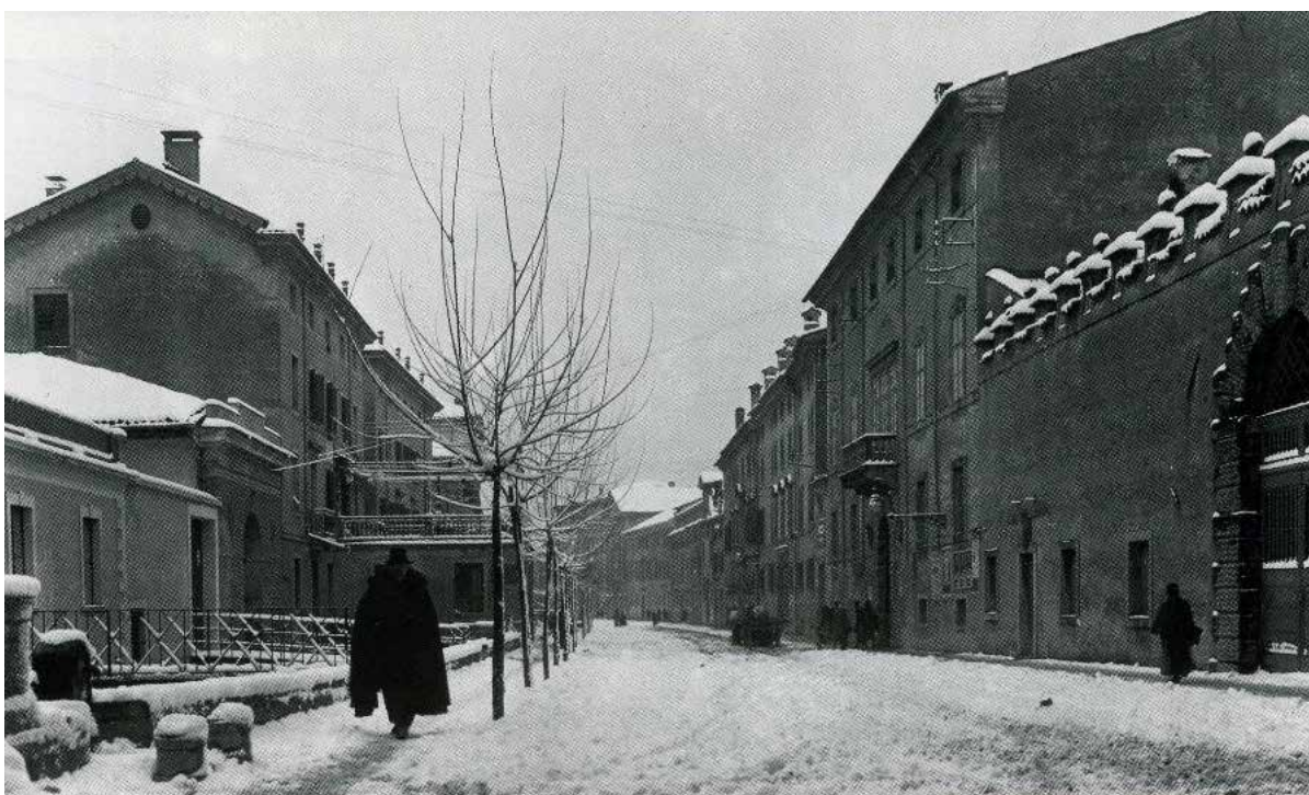
Zanon nel 1915 (B). A sinistra il ponte sulla roggia che immette in Corte Giacomelli. A destra la chiesa di San Nicolò, battuta e sostituita da un anonimo condominio.* Sotto, ancora Via Zanon nel 1915 (B).
