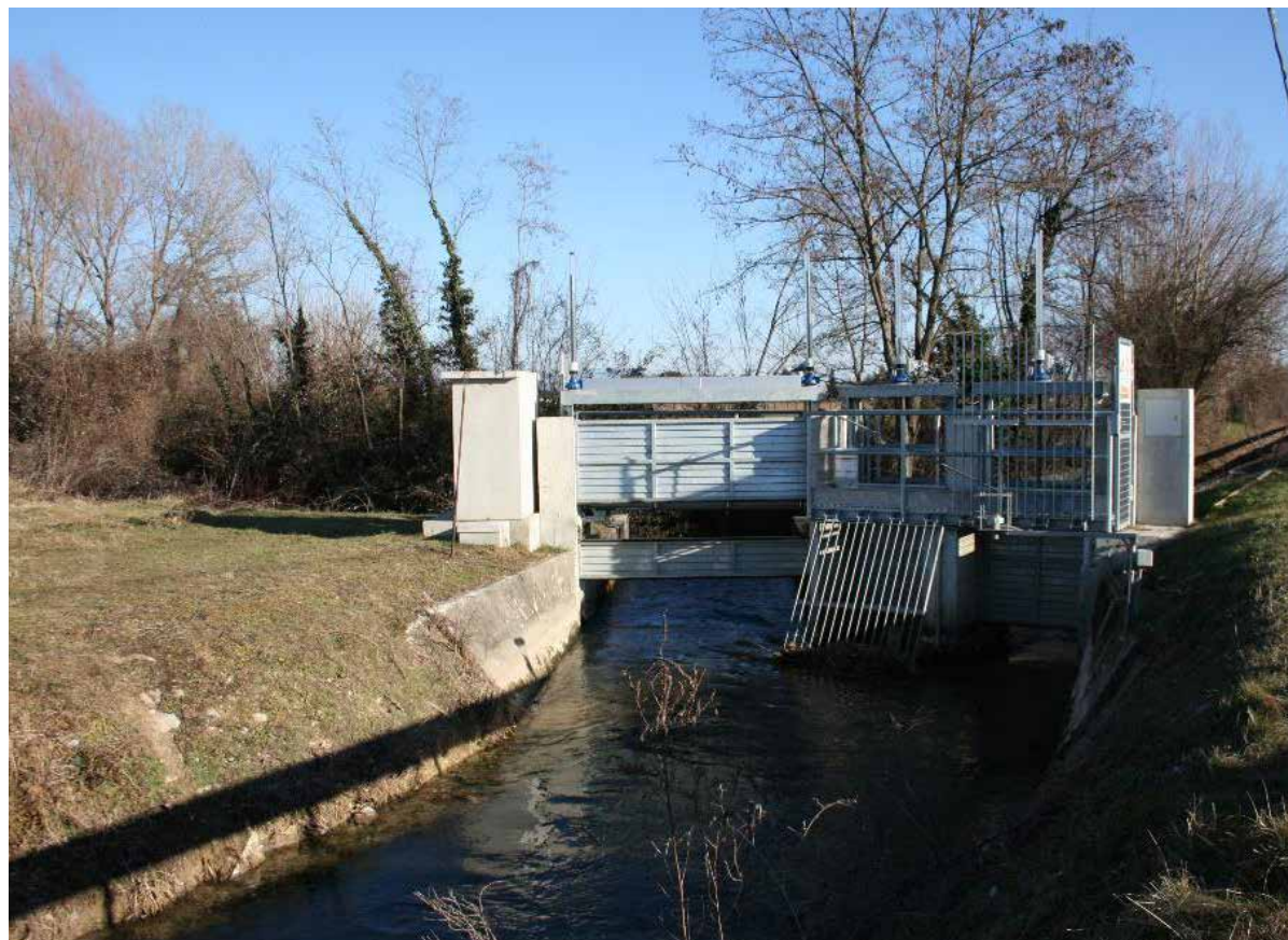
Nodo idraulico: le acque della roggia di Palma in parte si gettano nella roggia Brentana e in parte proseguono per Palmanova – IMG_0507
