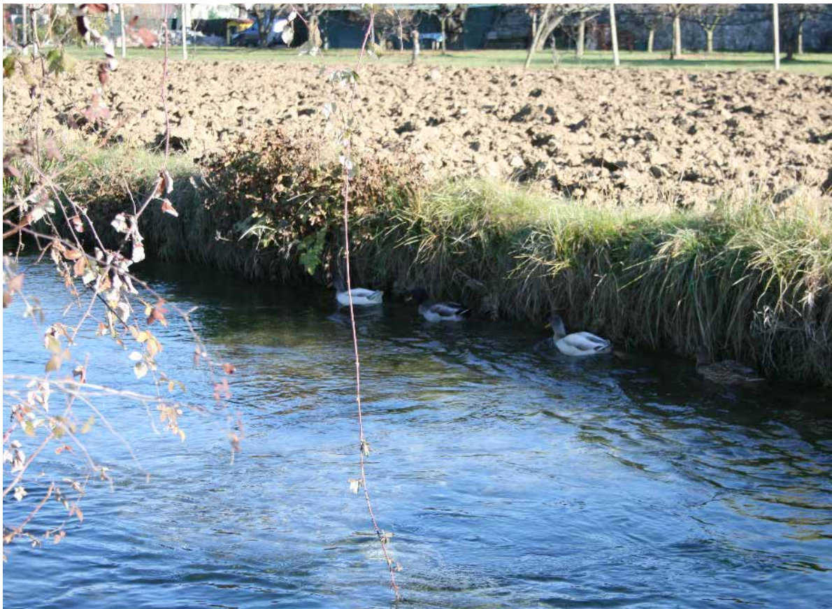
Sponde basse in cemento mascherate dall'erba a Sud di Cortale - IMG_8724
