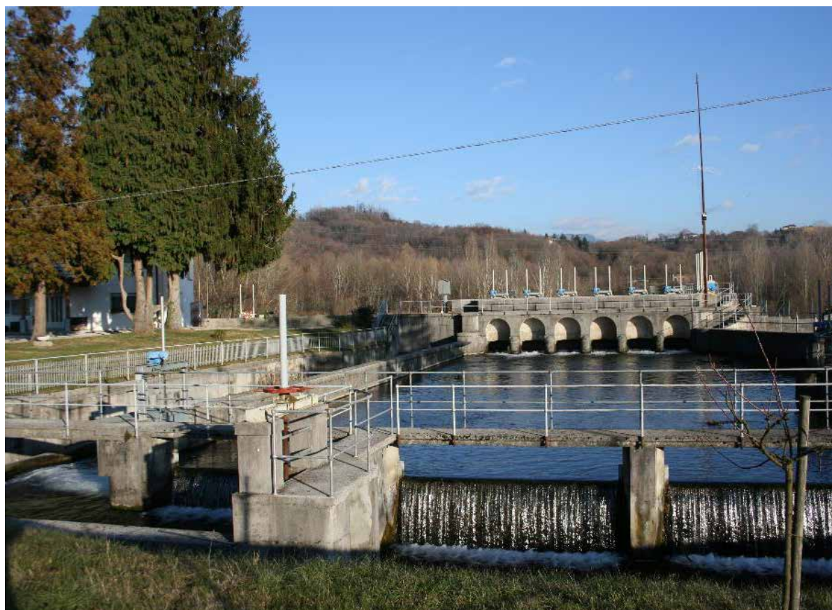
Le opere di presa progettate dall'ing. Cudugnello nel 1929 – IMG_8547
