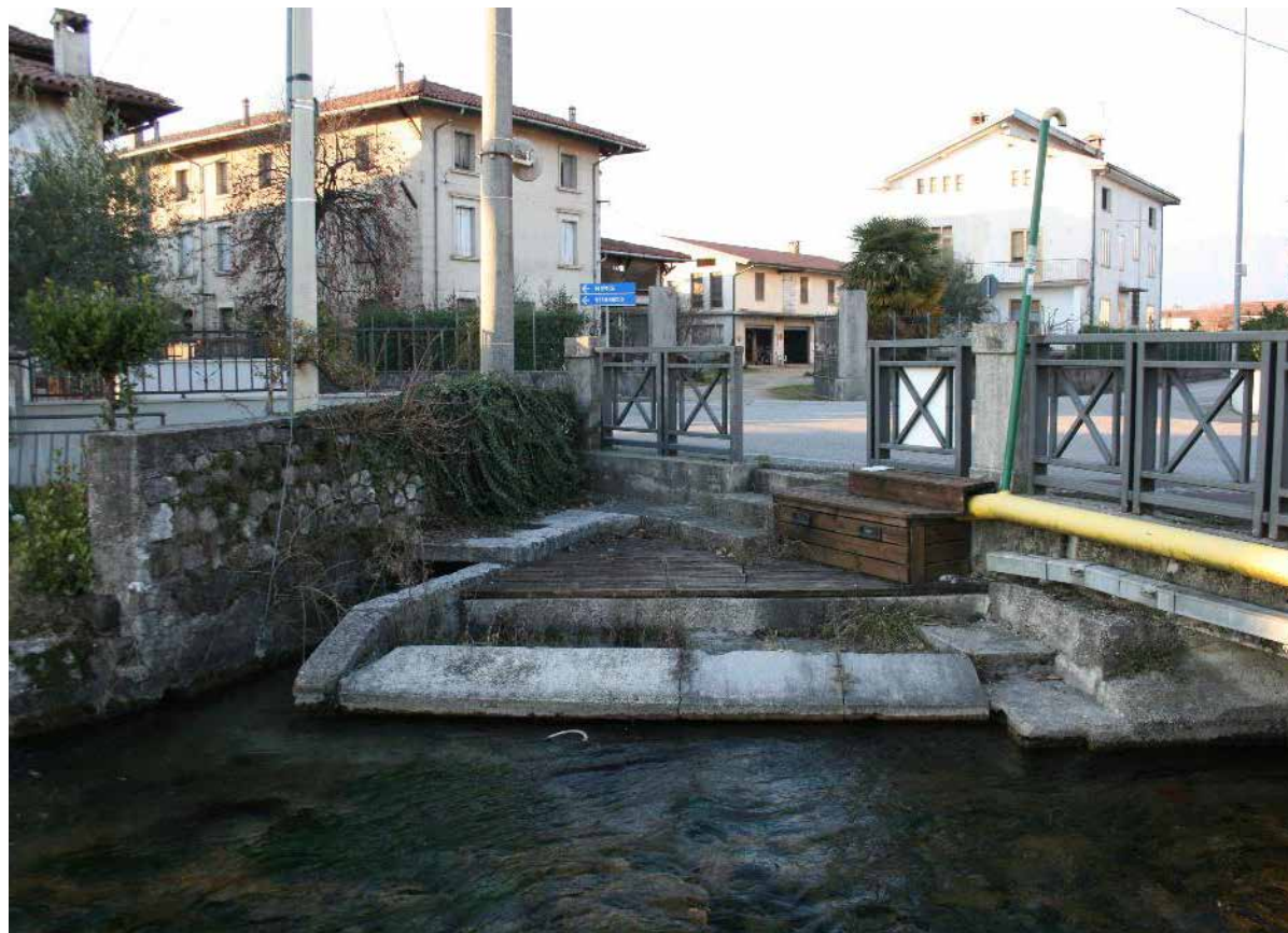
Antico lavatoio nel Borgo di Sotto lungo il canale principale parzialmente mascherato da arredi in legno - IMG_8610
