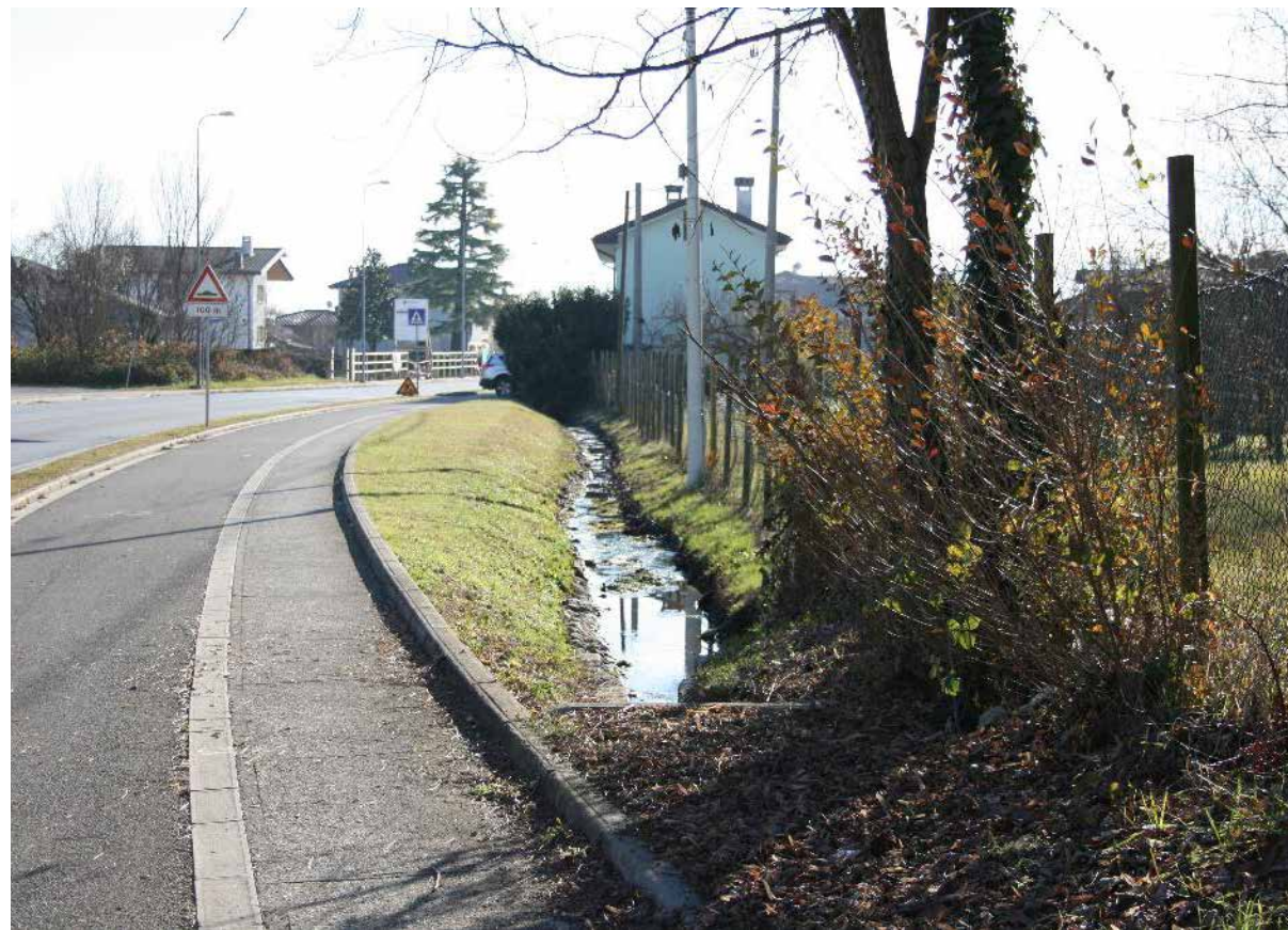
La derivazione del rociello di Pradamano dalla roggia di Palma presso Molino Vicario a Beivars - IMG_9113
