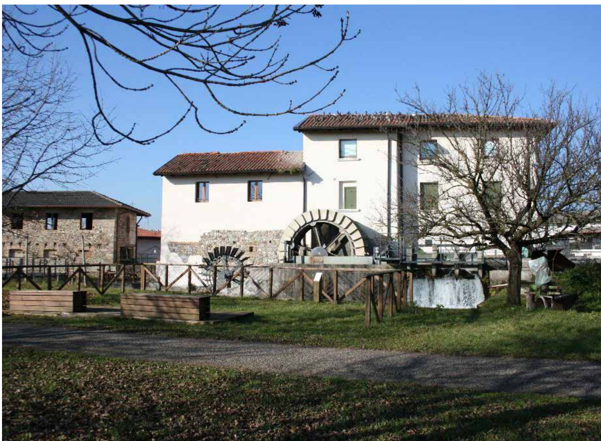
Opificio a Cavalicco sulla Roggia di Udine, recentemente ristrutturato con sostituzio- ne dei meccanismi idraulici – IMG_8961
