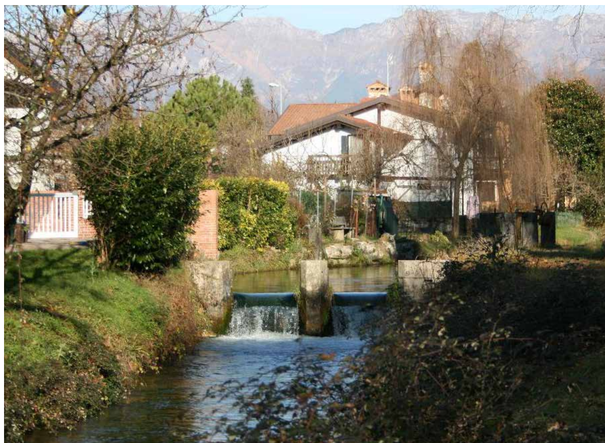
Salto d'acqua a Zompitta sul canale Principale con in secondo piano le chiuse per lo scarico dell'acqua nel T. Torre – IMG_8684
