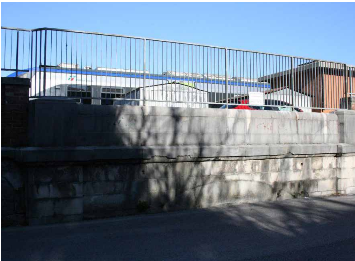
Il manufatto ferroviario di attraversamento della roggia di Palma in via della Cernaia - IMG_0275
