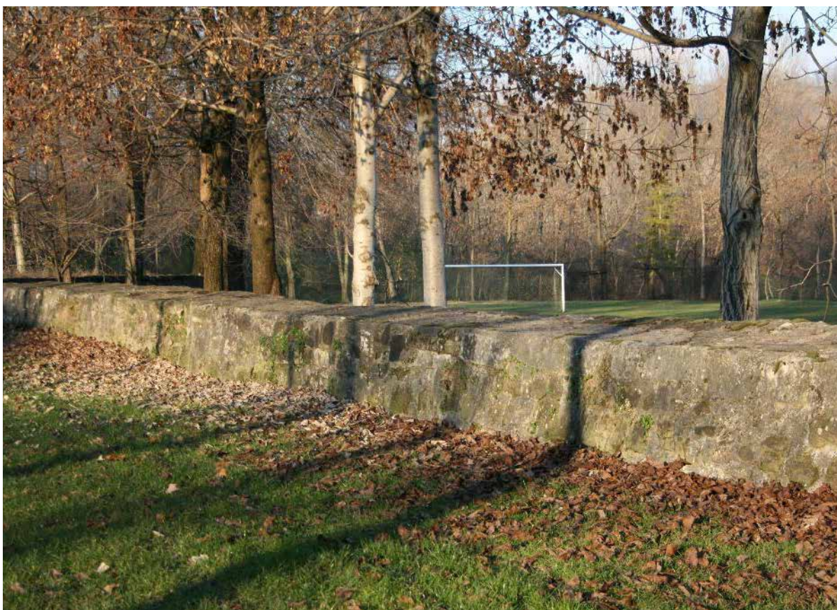
Particolare della rosta Ferracina – IMG_ 8588
