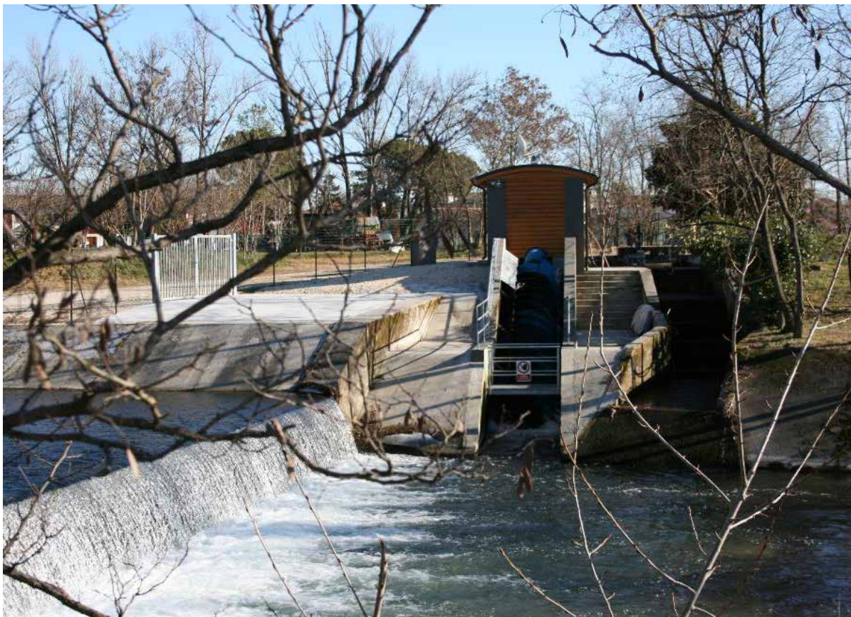
Le acque della roggia di Udine si immettono nel Cormor a Mortegliano. Una centralina ne sfrutta il salto – IMG 0788
