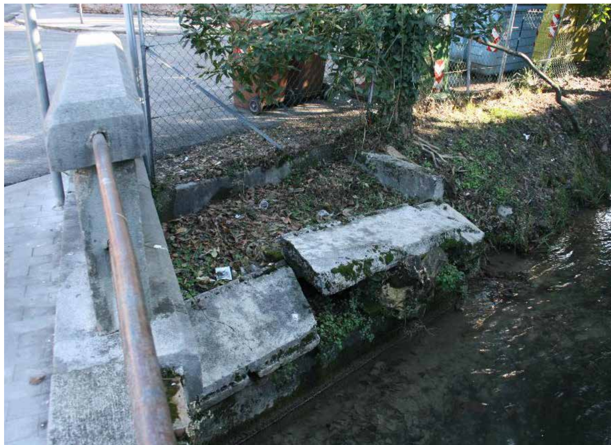
Lavatoio sulla roggia di Palma all'angolo tra via della Cernaia e via del Vascello - IMG_0278
