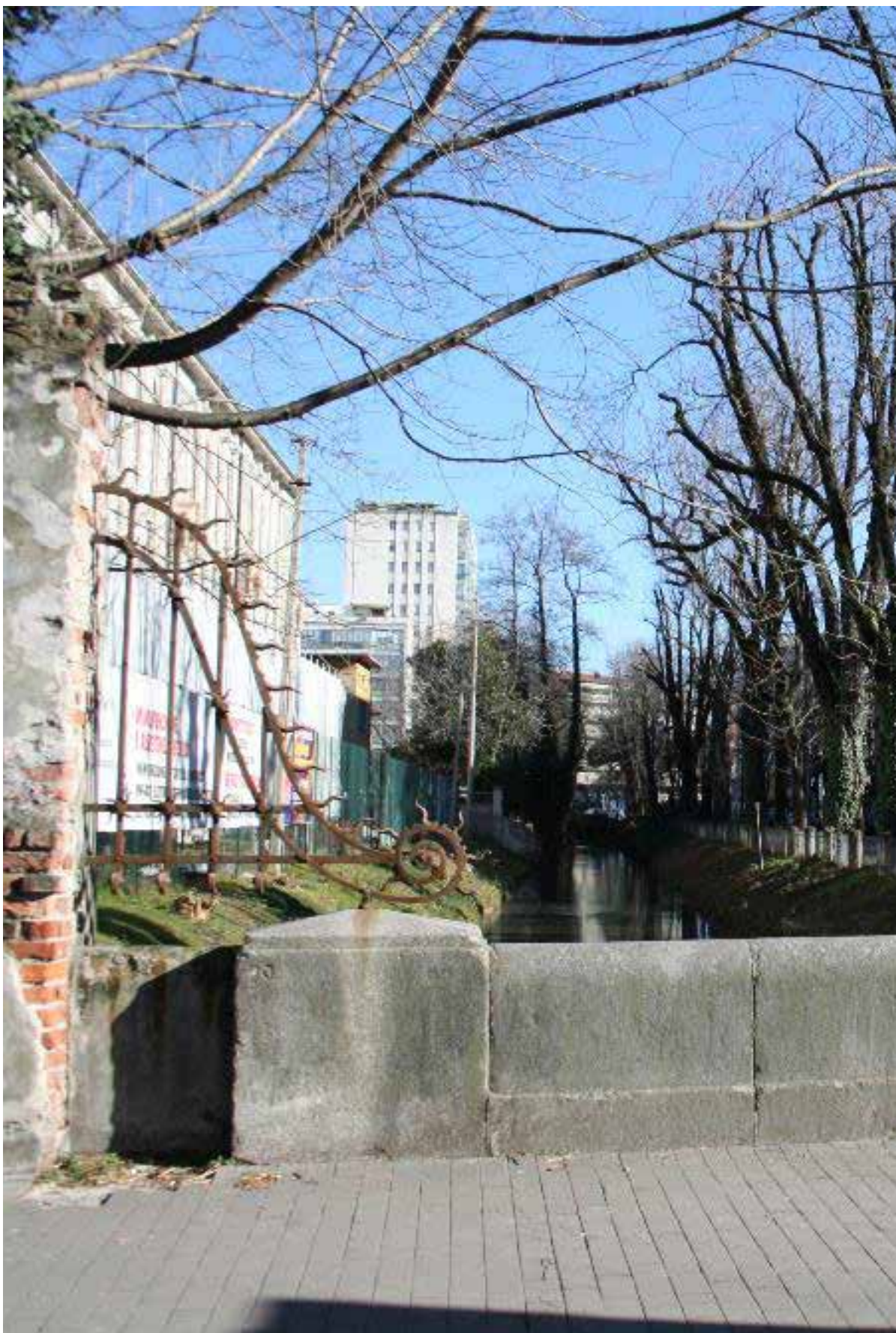
Parapetto via Manzoni lungo la roggia di Palma – IMG 0651
