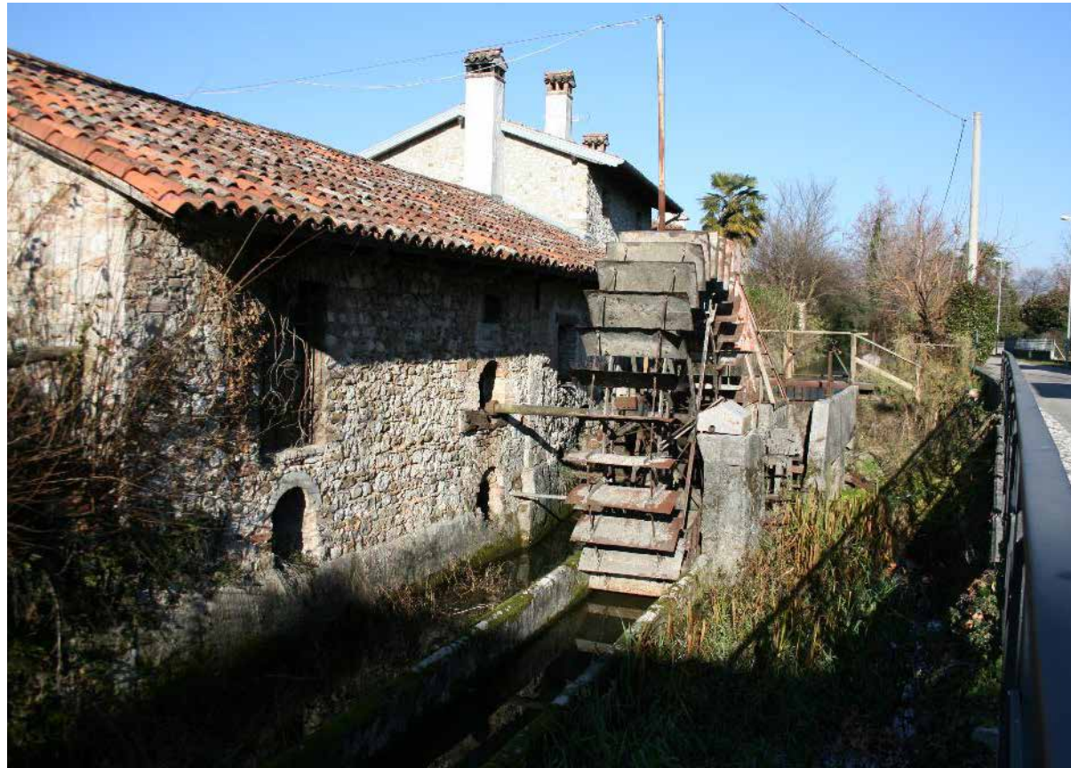
Opificio a Rizzolo con i meccanismi idraulici e il salto d'acqua sulla Roggia di Udine – IMG_8901
