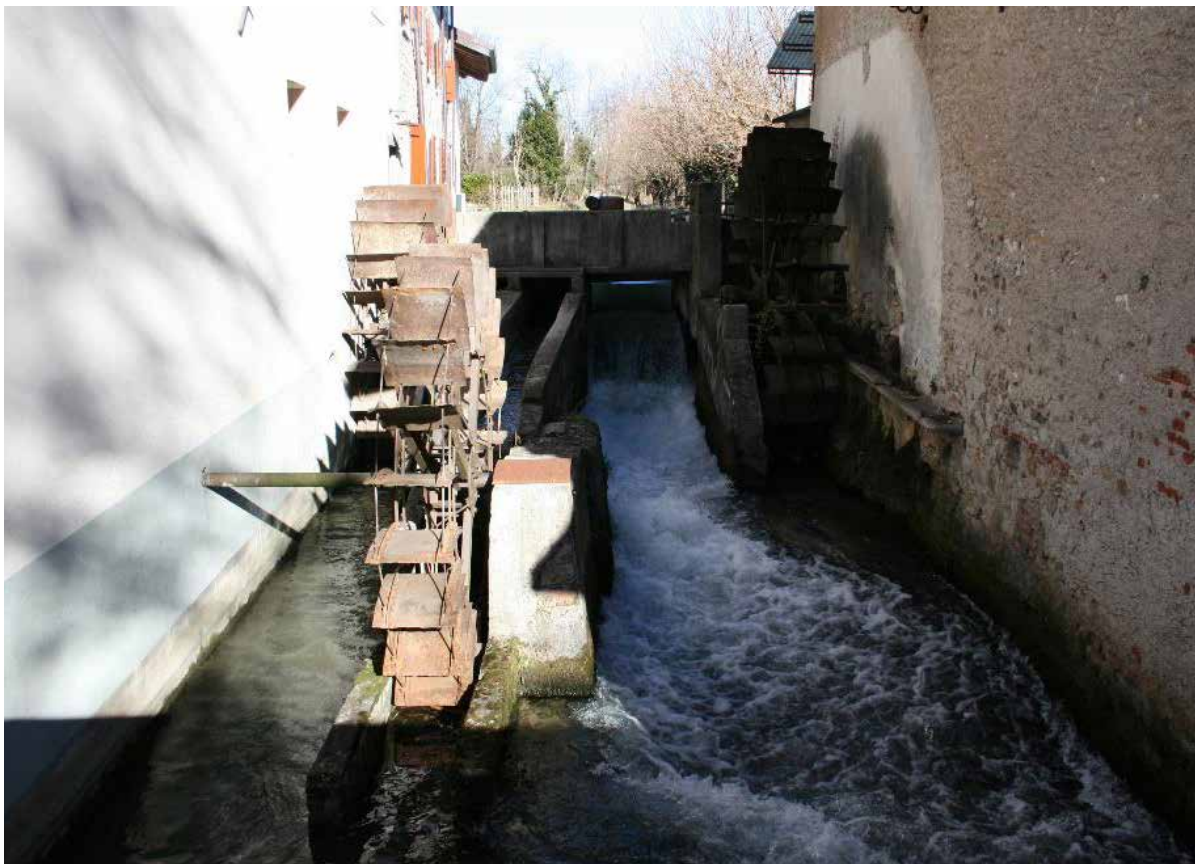
Salto d'acqua con ruote a Basaldella lungo la roggia di Udine – IMG 0711
