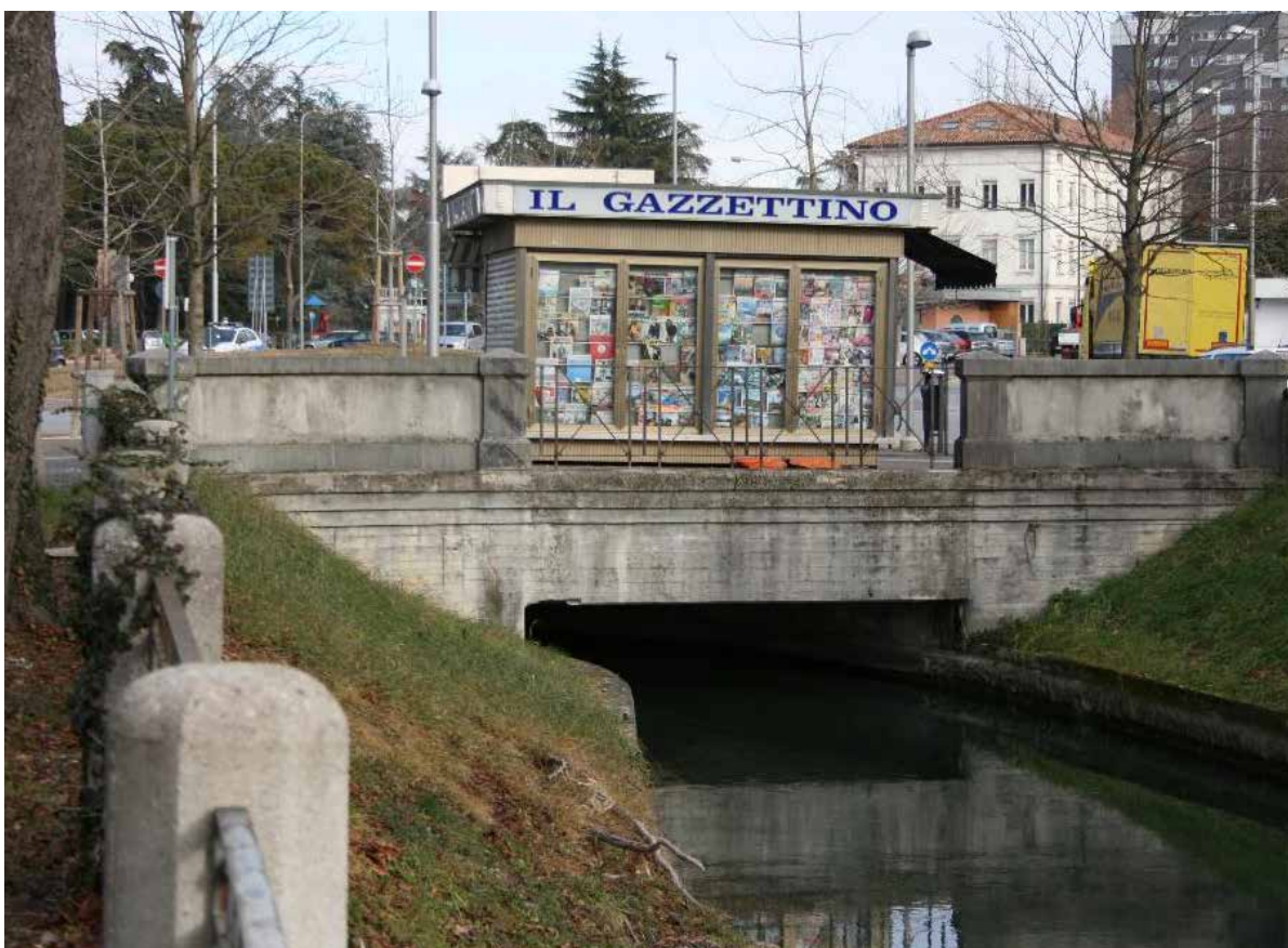
Parapetto attraversamento Canale Ledra in piazzale Diacono – IMG_0810
