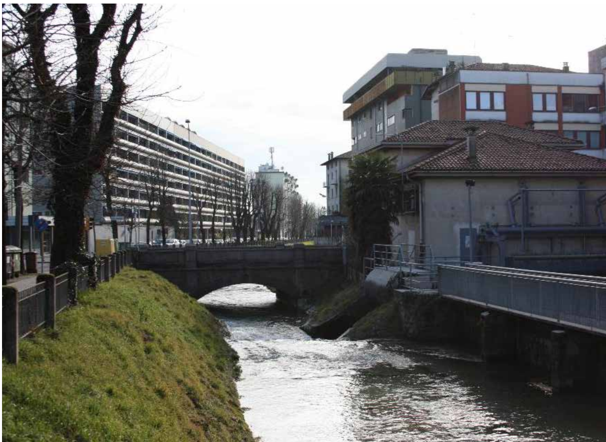
Salto d'acqua lungo il canale Ledra in via Marangoni e centralina storica – IMG_0896
