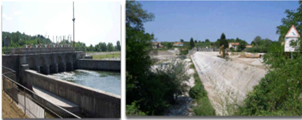
Figura 127 - Zompitta: presa e traversa sul torrente Torre
