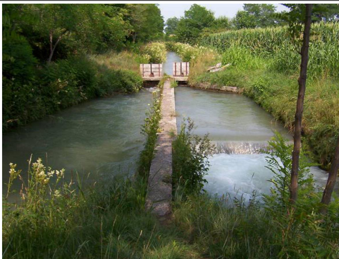
Figura 129 - Derivazione comizi a scorrimento in comune di Mereto di Tomba con derivazione dal canale di San Vito
