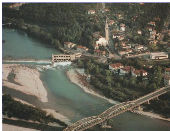
Figura 131 - Derivazione a usi irrigui e idroelettrici in comune di Sagrado
