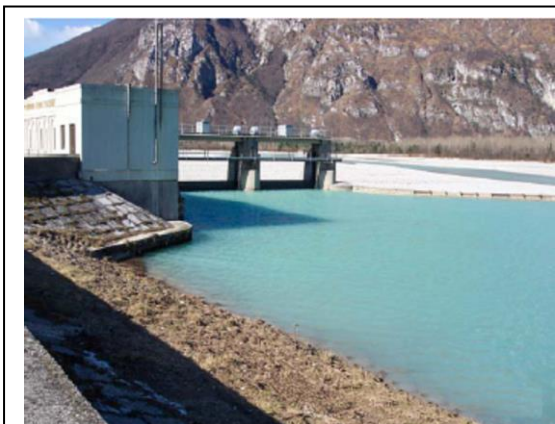
Figura 126 - Consorzio Ledra Tagliamento: opera di presa di Ospedaletto in comune di Gemona del Friuli
