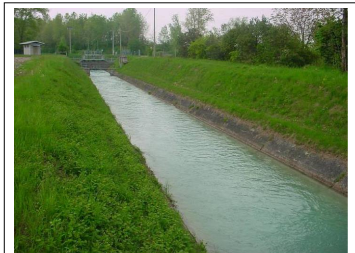
Figura 121 - Consorzio di bonifica Cellina Meduna: canale principale di Villa Rinaldi che alimenta i comizi irrigui a scorrimento nella zona nord di Pordenone compresa tra l'abitato di Cordenons e Fontanafredda
