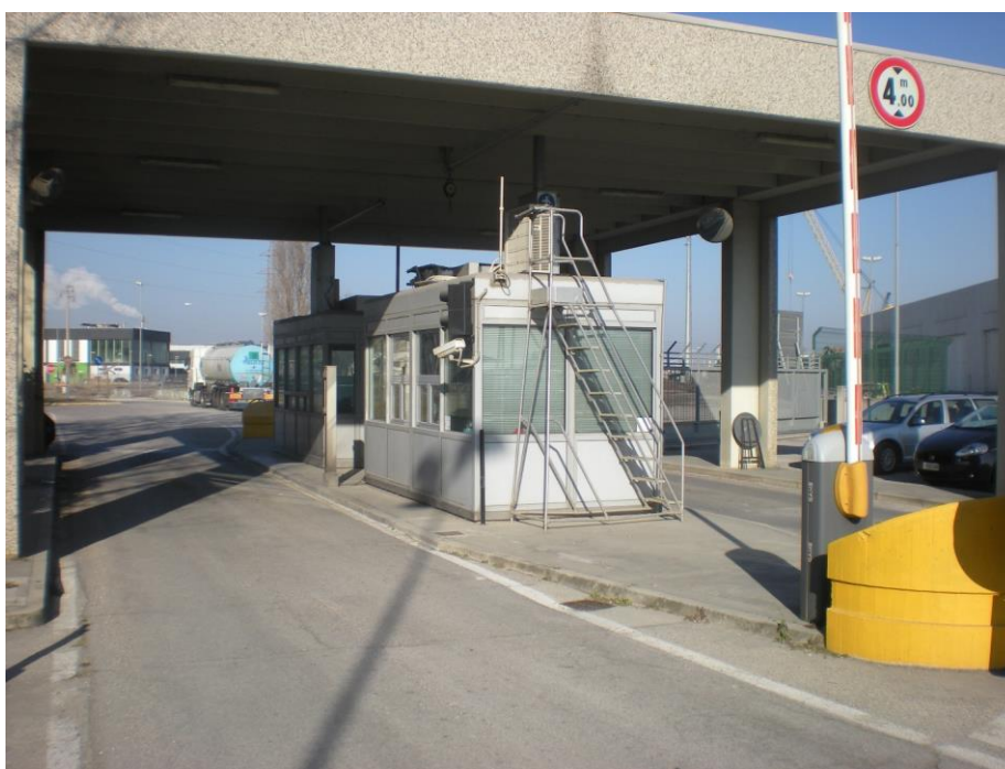
Figura 23 - Garitte presenti al varco di accesso di Porto Nogaro; fonte: immagine di CoSEF.
