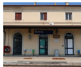
Mancato adeguamento banchine
