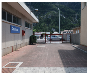
Potenziale accessibilità strada-banchina n.1
