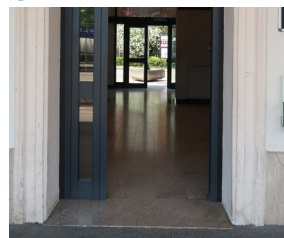
Accessibilità strada-edificio stazione-banchina
