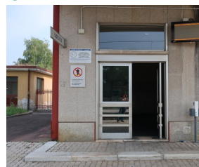
Area esterna videosorvegliata
