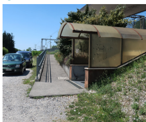
Accessibilità strada-banchina n.2
