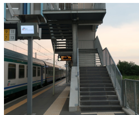
Presenza di sovrappasso dotato di ascensore
