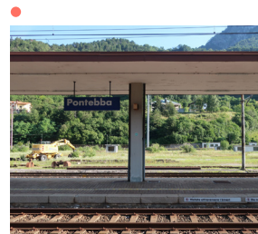
Mancato adeguamento banchine
