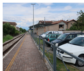
Mancanza adeguamento banchine
