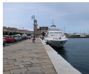
Accessibilità strada-"banchina di attracco"
