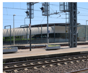
Mancato adeguamento banchine
