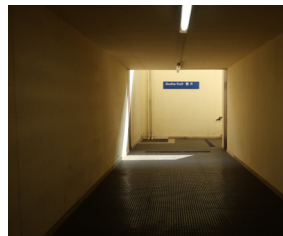
Presenza sottopassaggio tra le banchine
