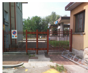
Assenza accessibilità strada-banchina 1
