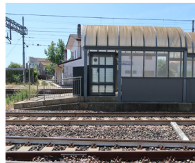
Parziale adeguamento banchine
