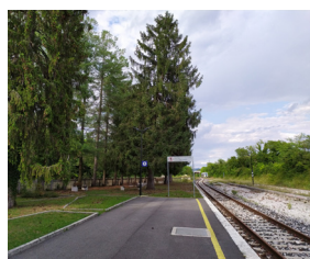
Mancato adeguamento banchine
