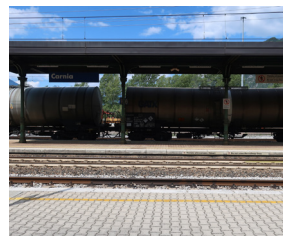
Assenza adeguamento banchine
