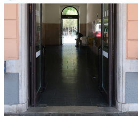
Accessibilità strada-edificio stazione-banchina n.1
