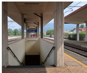
Assenza sistemi che garantiscano l'accessibilità tra le banchine
