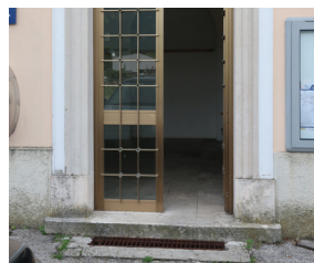
Assenza accessibilità strada-edificio stazione
