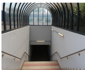
Assenza adeguata accessibilità tra banchina 1-altre banchine
