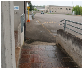
Presenza rampa strada-banchina
