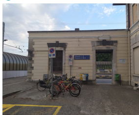
Presenza stalli biciclette in prossimità dell'edificio stazione
