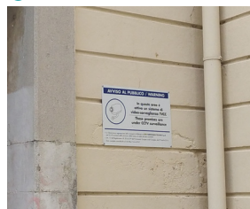
Presenza sistema videosorveglianza
