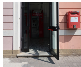
Mancata accessibilità edificio strada - stazione
