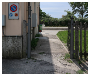
Accessibilità strada-banchina n.1
