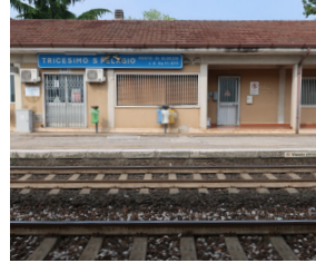
Mancanza adeguamento banchine
