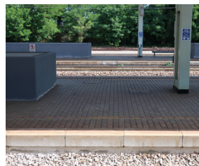
Mancato adeguamento banchine
