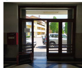
Accessibilità strada-edificio stazione-banchina n.1
