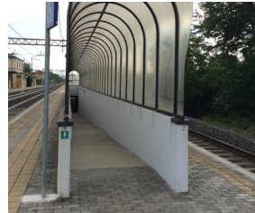
Rampa di accesso al binario 2 e 3
