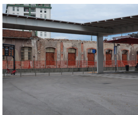
Presenza banchine coperte
