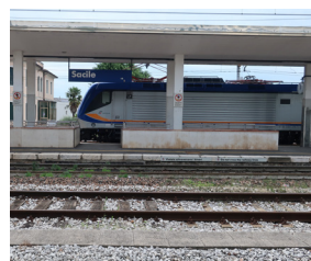
Mancato adeguamento banchine
