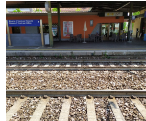
Mancato adeguamento banchine
