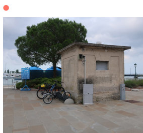
Assenza banchina coperta
