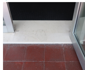
Accessibilità strada-edificio stazione-banchina n.1
