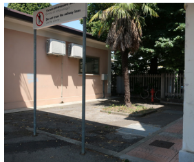
Presenza sottopasso tra le banchine e ascensore non adeguato a dimensioni bici
