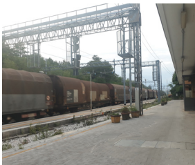
Assenza di adeguamento delle banchine della stazione
