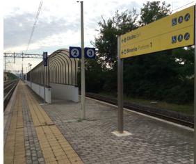
Accessibilità al binario 2 e 3 tramite rampa
