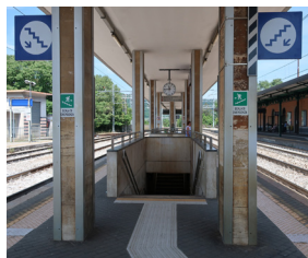
Assenza di sistemi che garantiscano l'accessibilità tra le banchine
