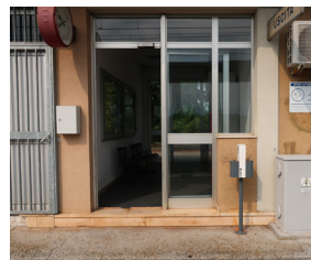
Mancanza accessibilità edificio stazione-banchina n.1
