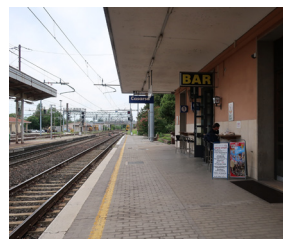
Assenza adeguamento banchine
