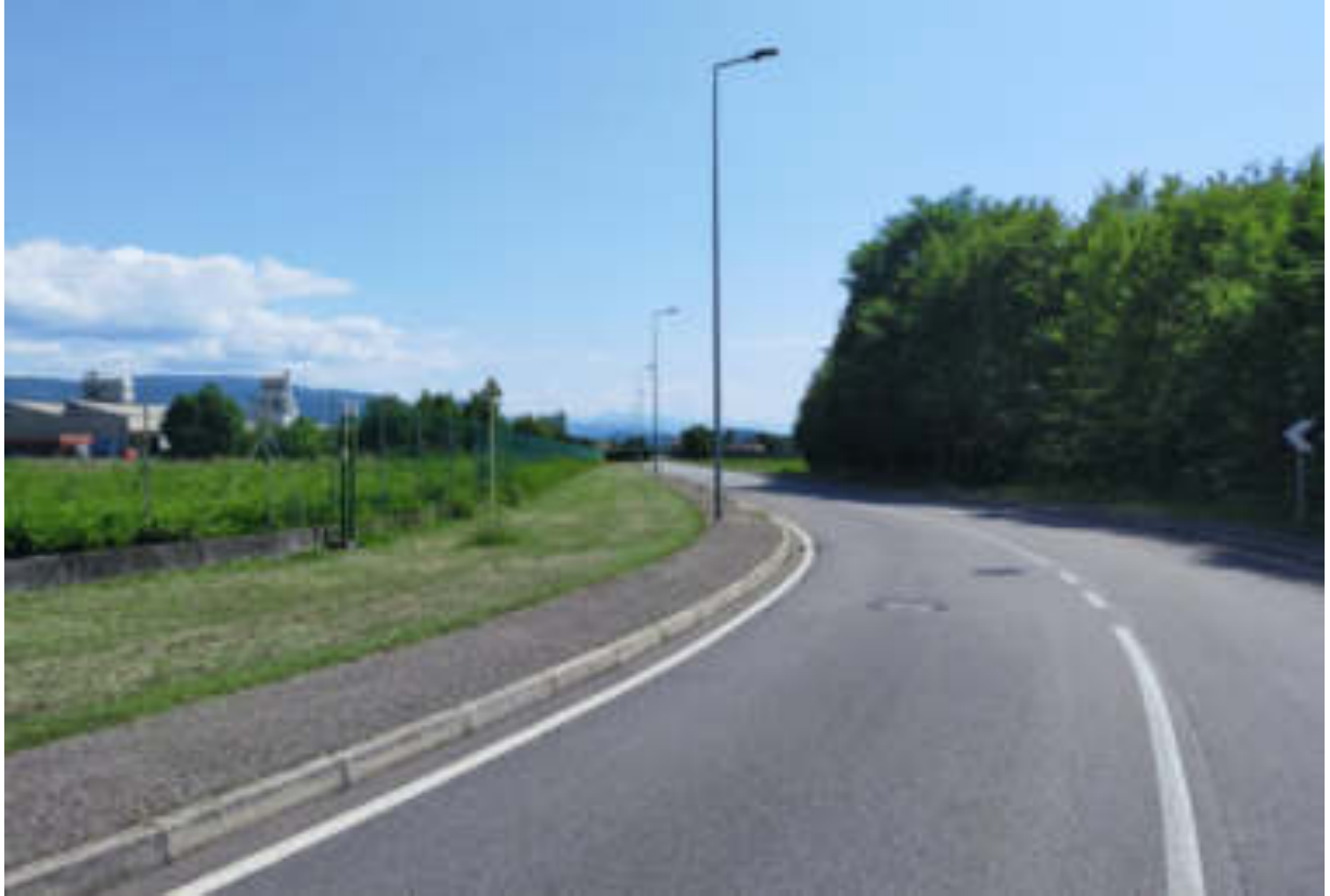
FOTO 15 - Vista di via Ponte Giulio in direzione est
