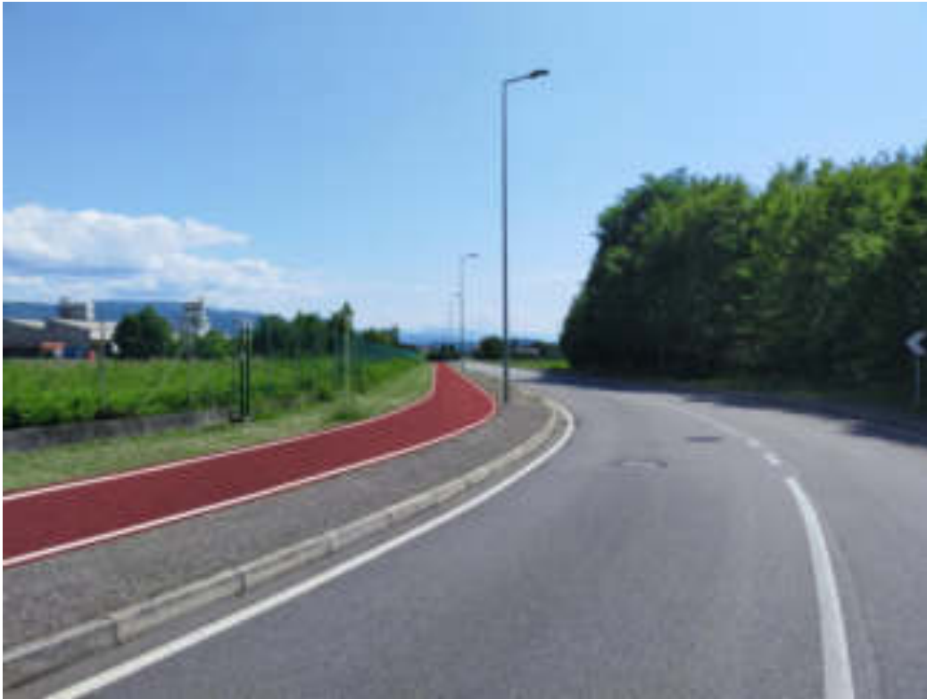
LOTTO F - Vista di progetto del tratto in via Ponte Giulio (direzione est)
