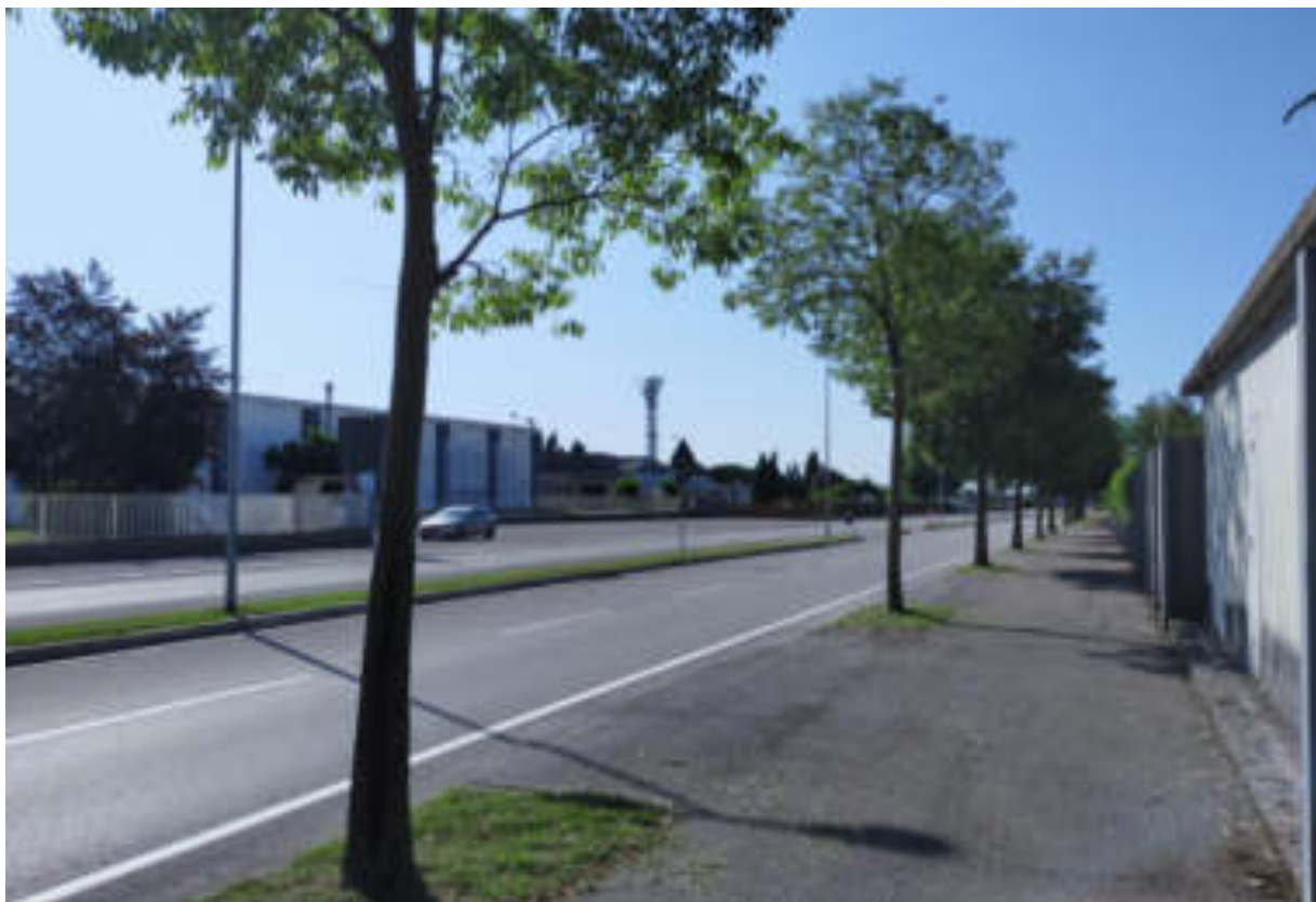
FOTO 5 – Vista del marciapiede lungo via dell'Industria in direzione sud
