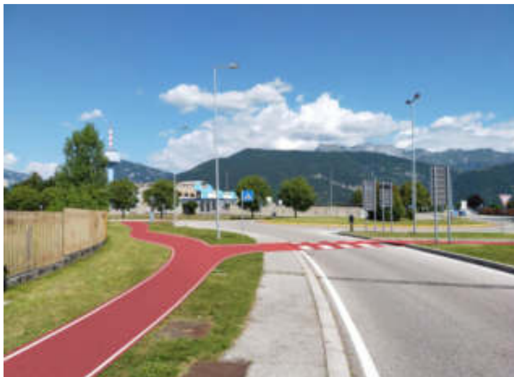
LOTTO D - Vista di progetto del tratto centrale in via dell'Industria (direzione nord)
