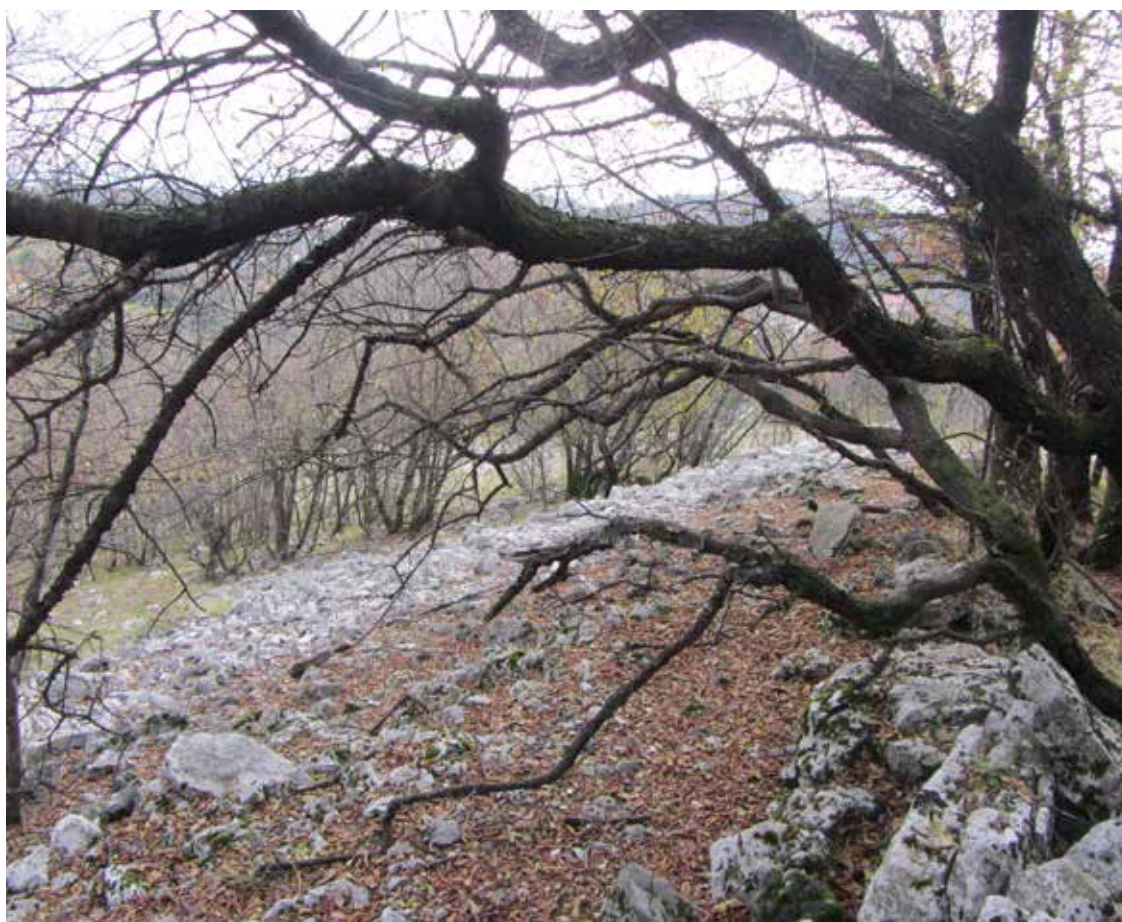
4. Le macerie del circuito difensivo in corrispondenza del versante orientale (da nord verso sud).
