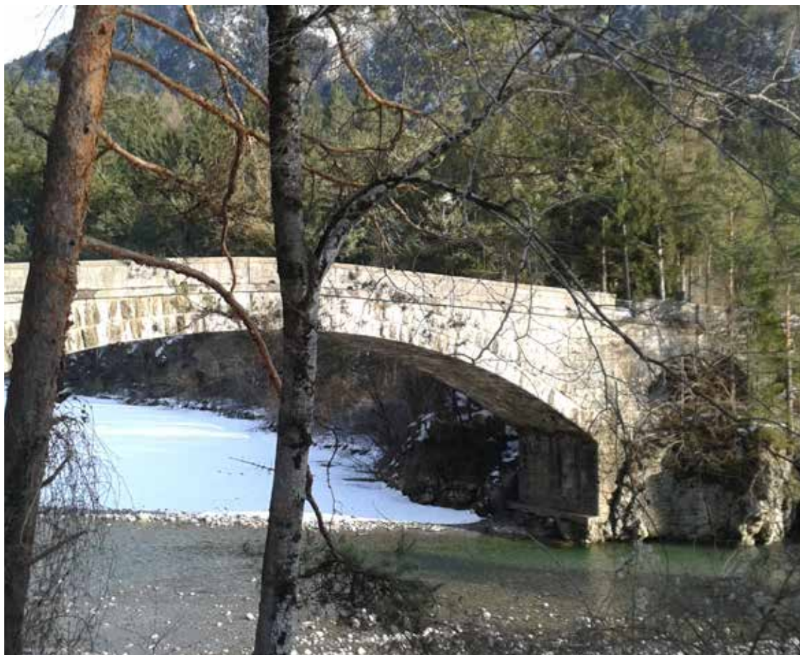
2. Il ponte che consente l'attraversamento del Fiume Tagliamento in direzione di Verzegnis.
