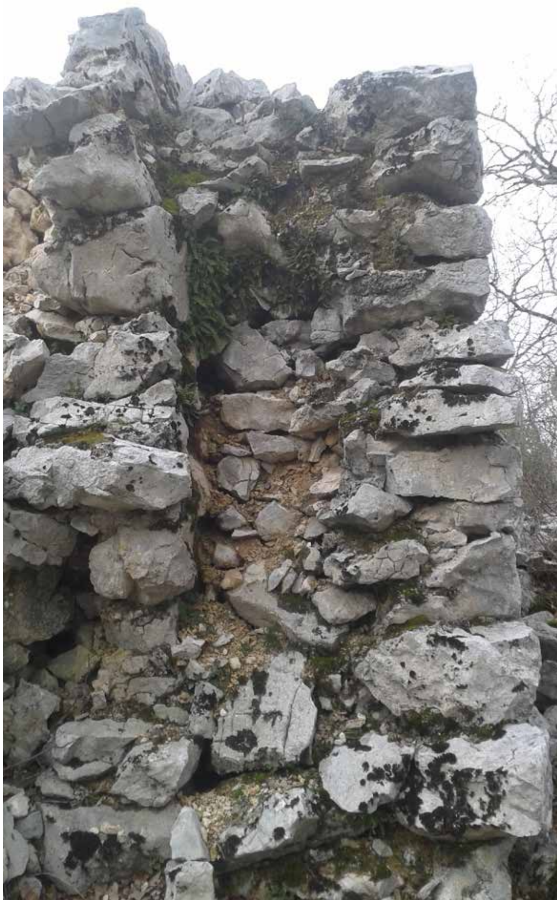
12. Particolare dell'apparato difensivo.
