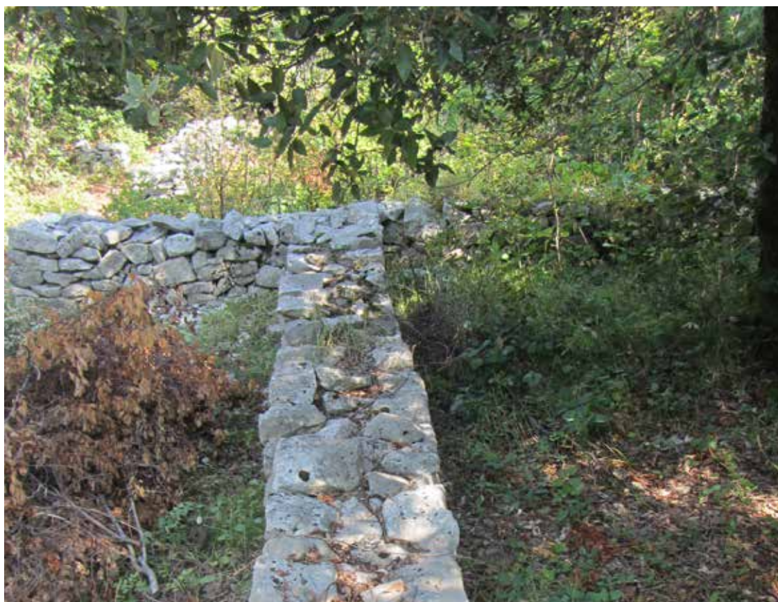
3. Le murature a secco conservate tra la boscaglia carsica.
