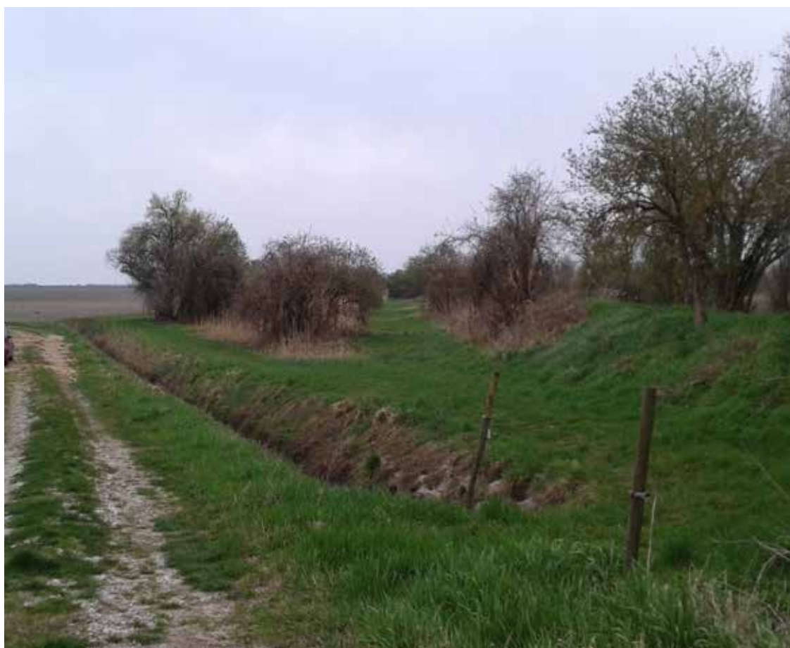
8. Il Canale Anfora in prossimità della laguna si presenta come un rilevato di terra.
