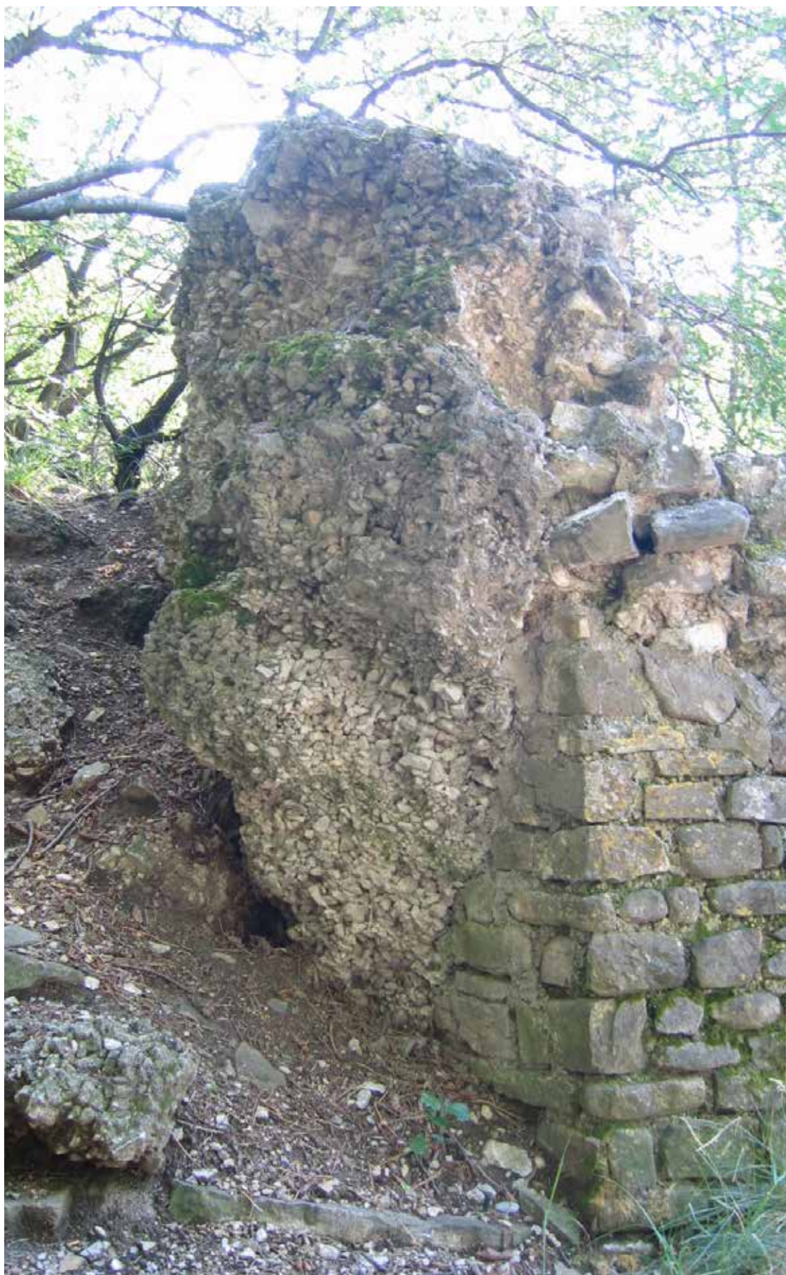
12. L'imponente sostruzione dell'acquedotto romano di Bagnoli della Rosandra.
