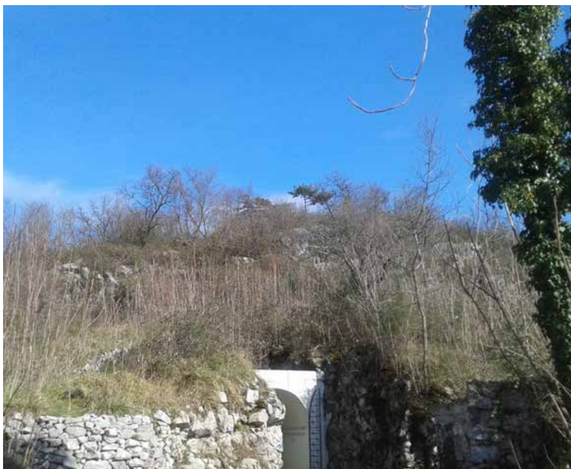
6. Uno dei due ingressi delle cannoniere recentemente valorizzate nel percorso di fruizione delle opere della Grande Guerra.
