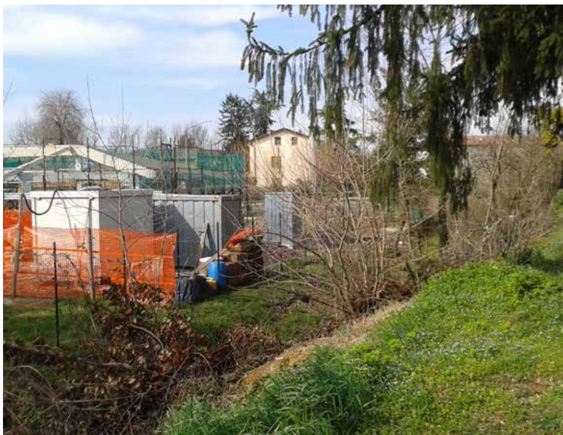
5. Particolare del versante meridionale del rialzo e la roggia oggi asciutta. L'alveo è in parte occupato da ramaglie e scarichi antropici. Ben visibile la costruzione o ristrutturazione di un edificio privato a sud della roggia.
