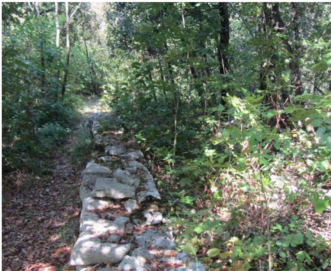
4. Le murature dell'edificio conservate tra la boscaglia carsica.
