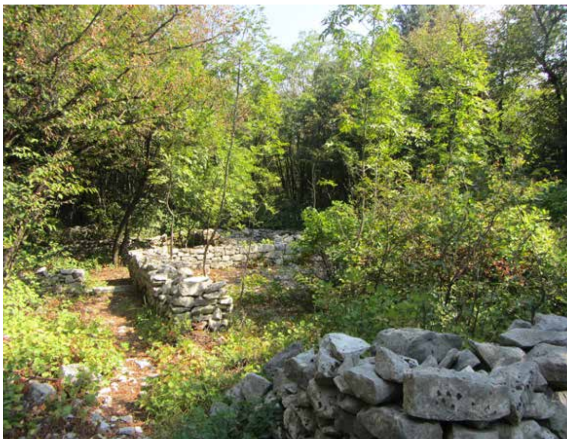
5. Gli ambienti dell'edificio localizzato nei pressi della Torre piezometrica.
