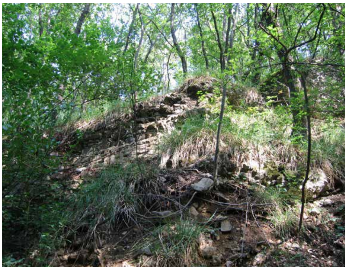
8. Resti dell'acquedotto ricoperti dalla vegetazione spontanea.
