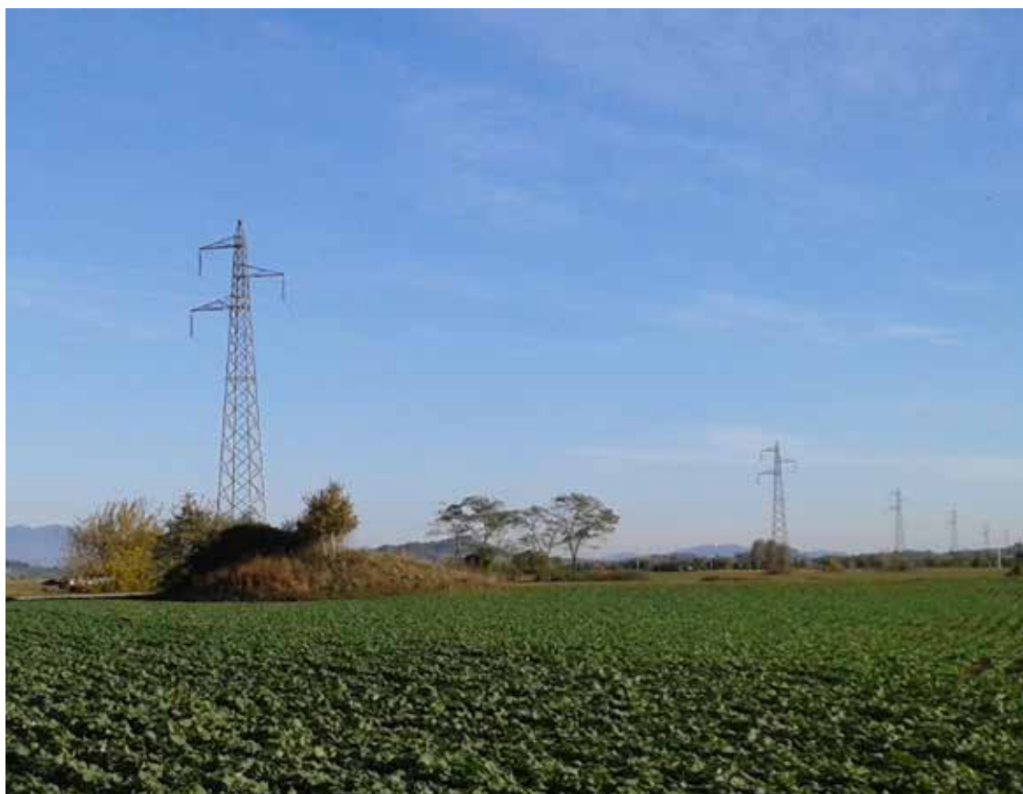
5. Il tumulo di Lonzan e la linea di pali della linea elettrica.
