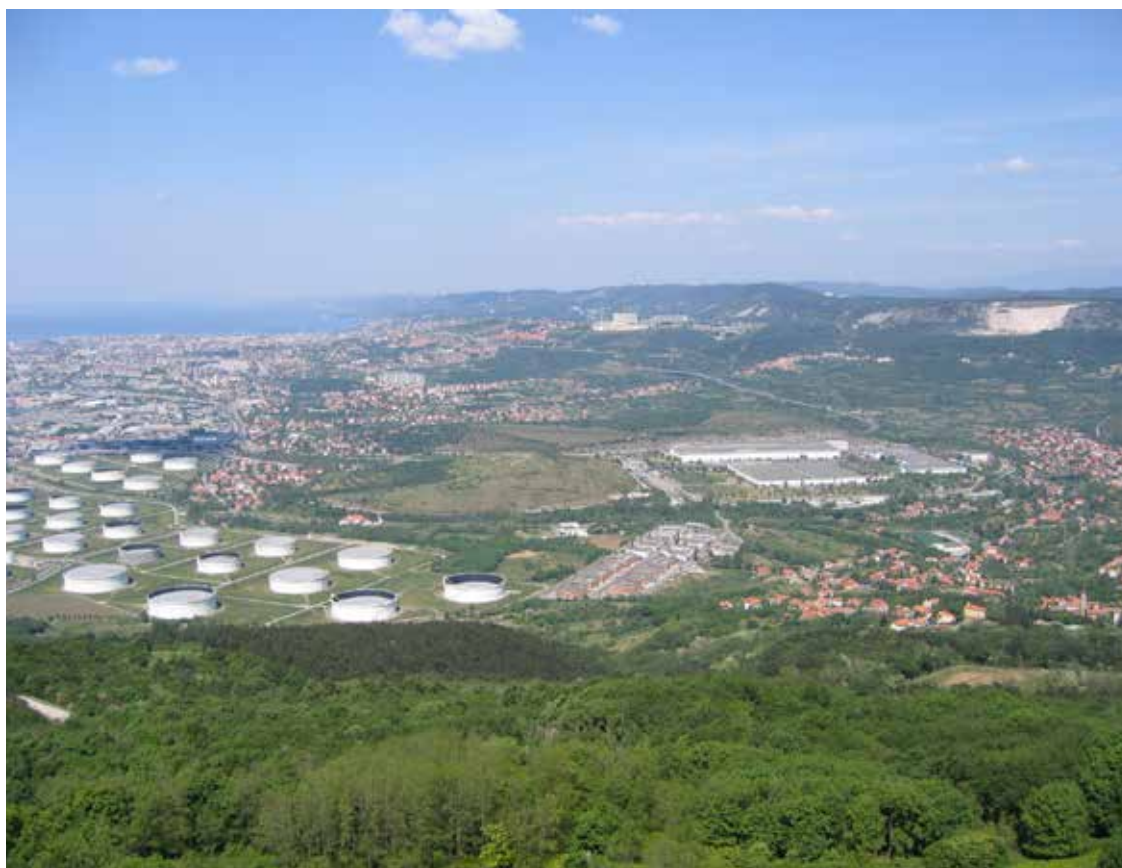
3. La piana del torrente Rosandra ripresa da San Servolo. Il Monte San Rocco si colloca tra lo stabilimento Wärtsilä e i serbatoi della Siot.
