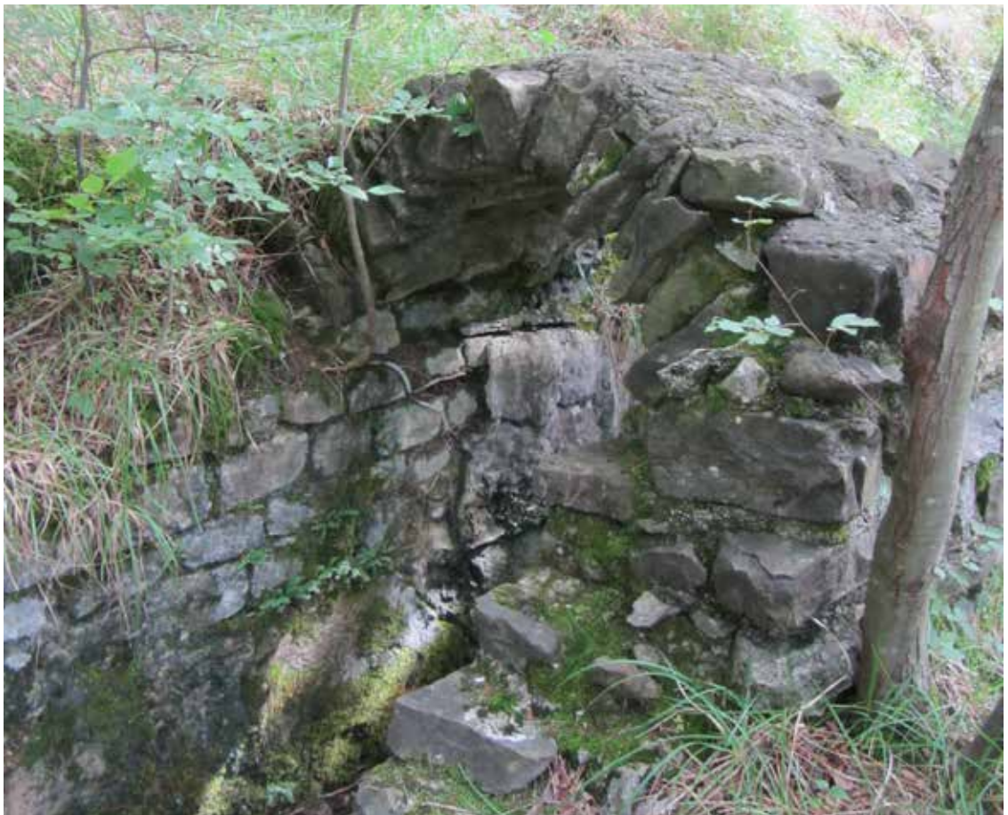
4. Particolare della volta dell'infrastruttura idrica.
