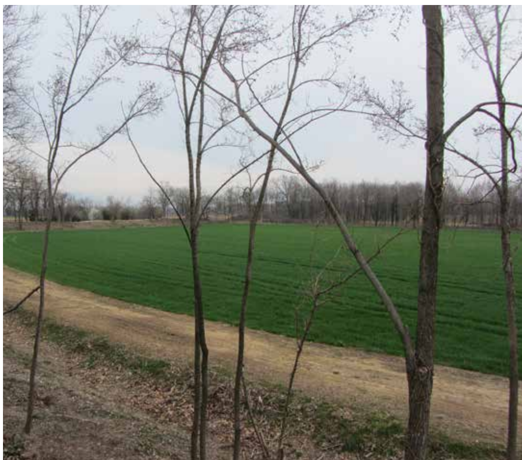
8. Veduta dell'aggere (lati occidentale e settentrionale) e della spianata interna.
