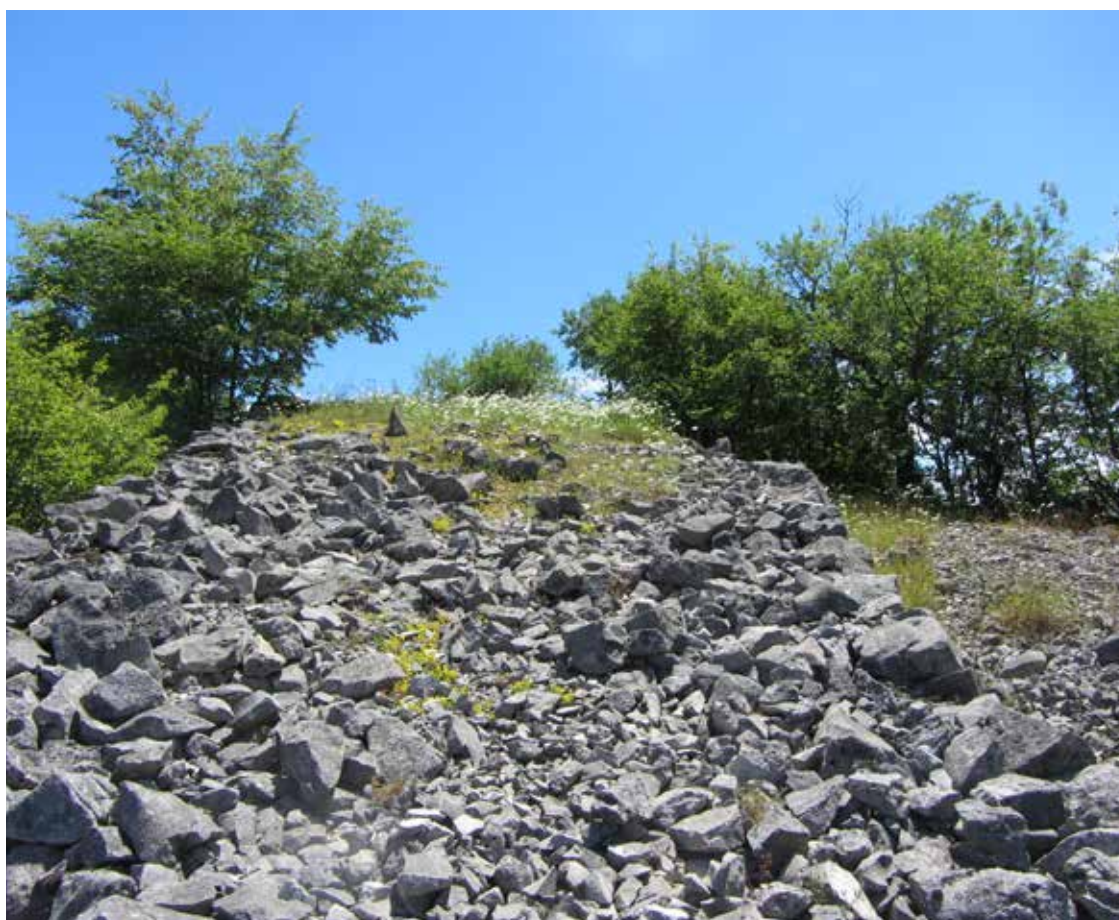
6. Particolare della cinta in pietrame accumulato a secco.
