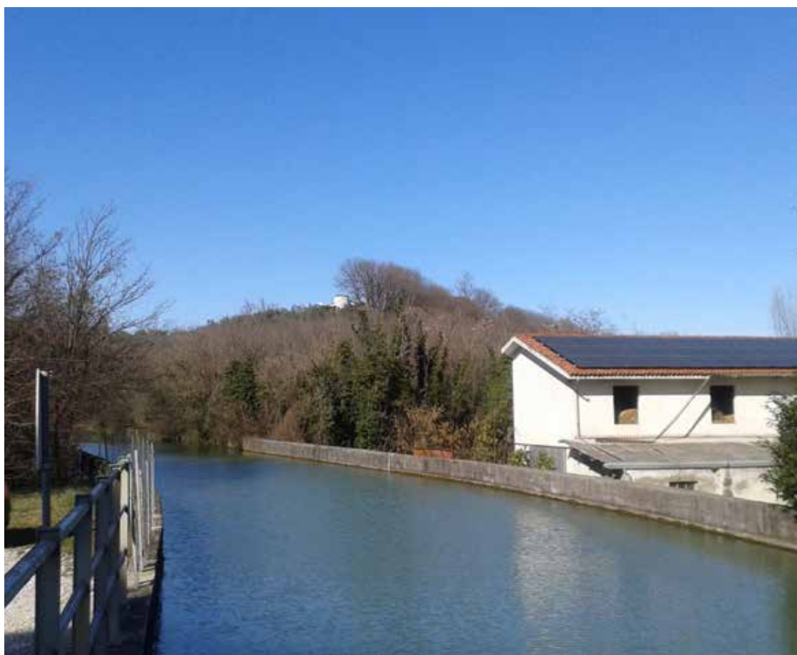
8. Il terrazzo visibile dal canale Leda-Tagliamento (da sud verso nord).
