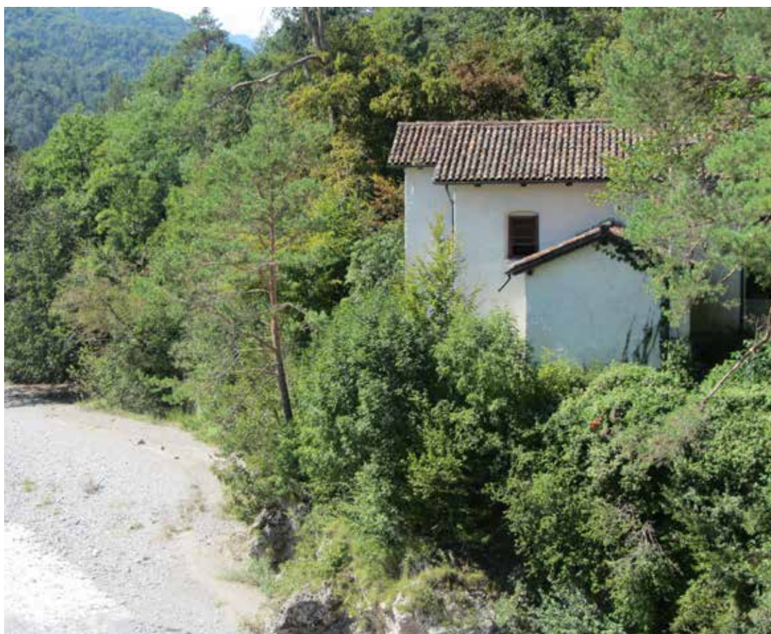
4. La cappella della Madonnina del Ponte sorge su uno sperone roccioso a ridosso dell'alveo del Tagliamento.
