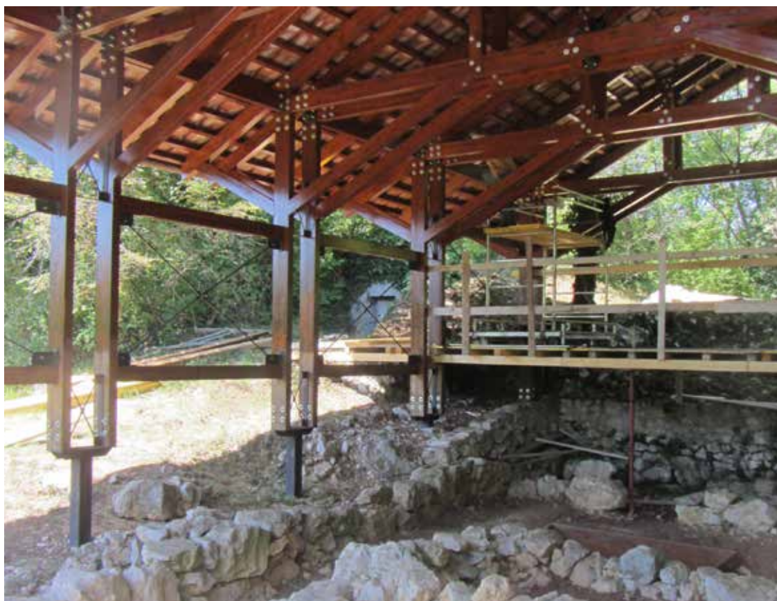
10. Una delle coperture attualmente in fase di ripristino.
