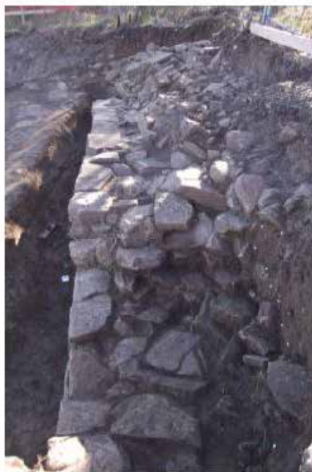
8.8 - Sezione trasversale della struttura muraria con in evidenza la fossa di fondazione sulla sinistra, il paramento esterno e lo strato di riempimento a sacco.
