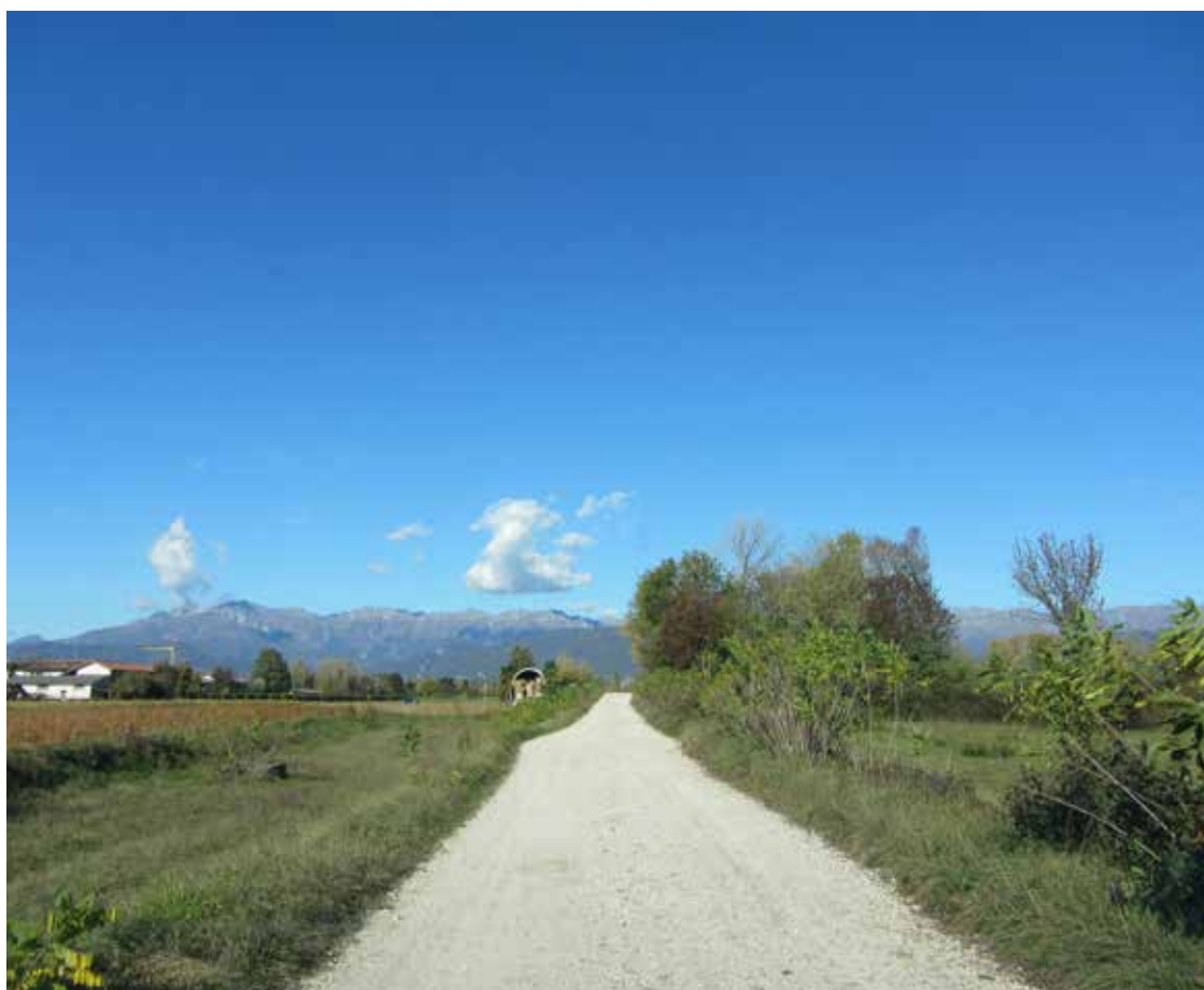
8. La strada bianca che corre sulla sponda destra del Torre riprende l'orientamento di un cardine.
