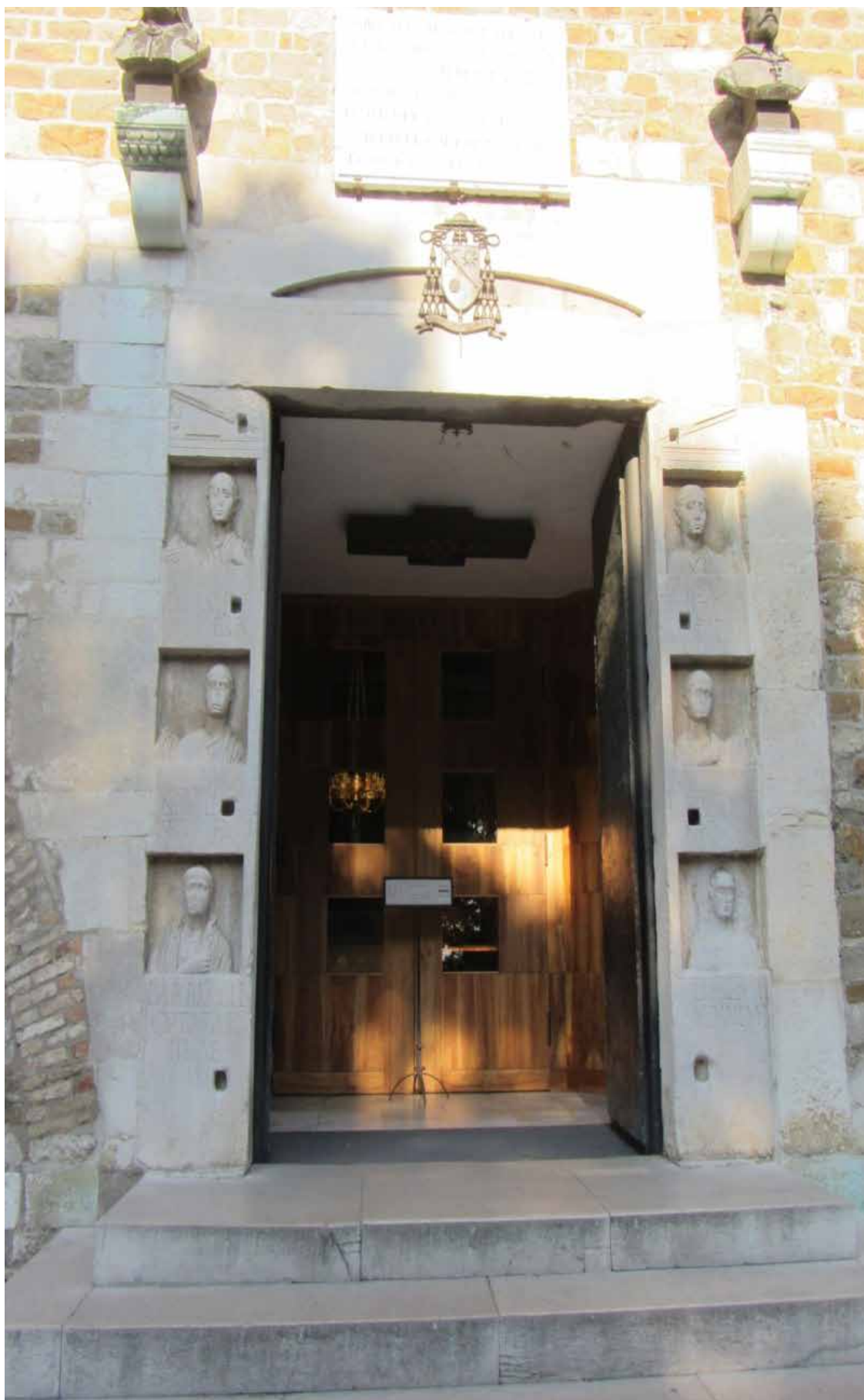
22. Portale principale della Cattedrale di San Giusto. Per gli stipiti venne recuperata una stele sepolcrale romana appartenuta alla gens Barbia segata a metà nel senso dell'altezza (i due frammenti sono stati invertiti).
