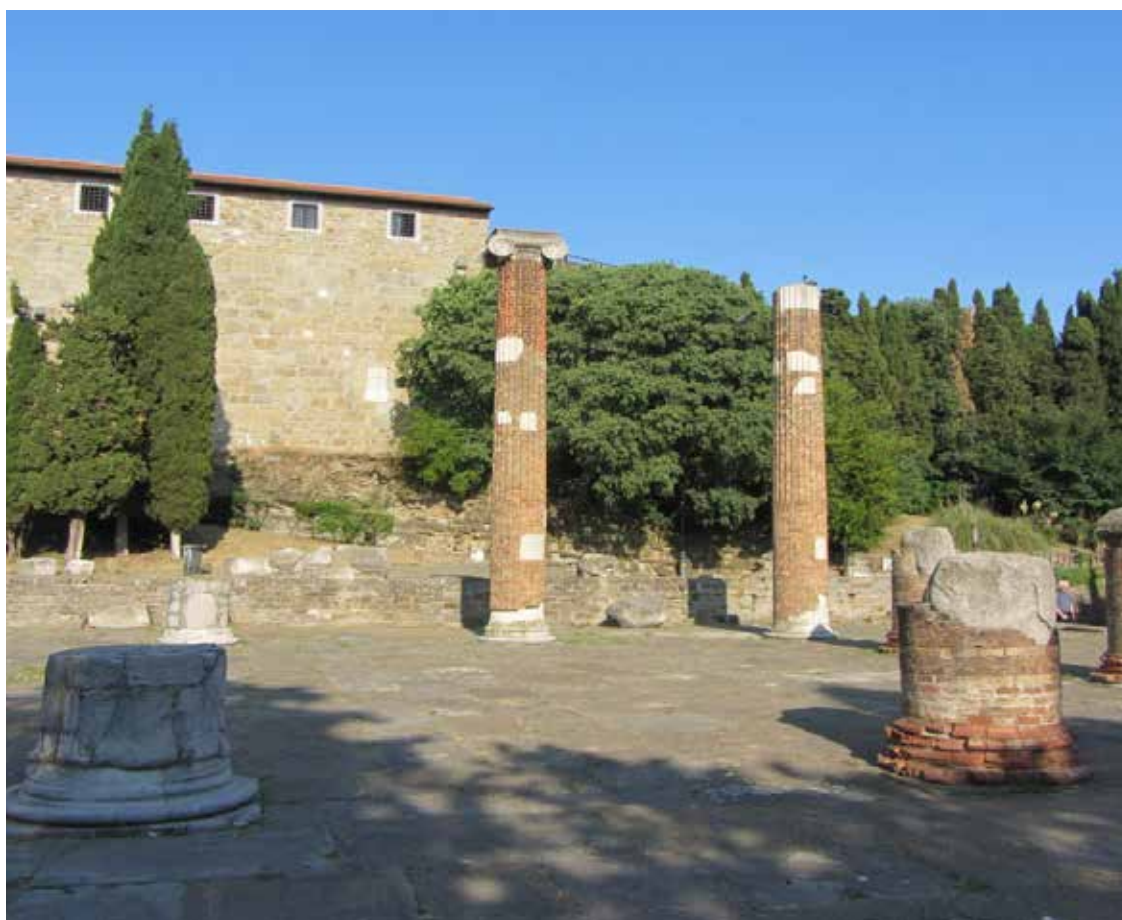
15. Elementi della basilica civile inglobati nelle colonne di mattoni realizzate negli anni '30 del Novecento.
