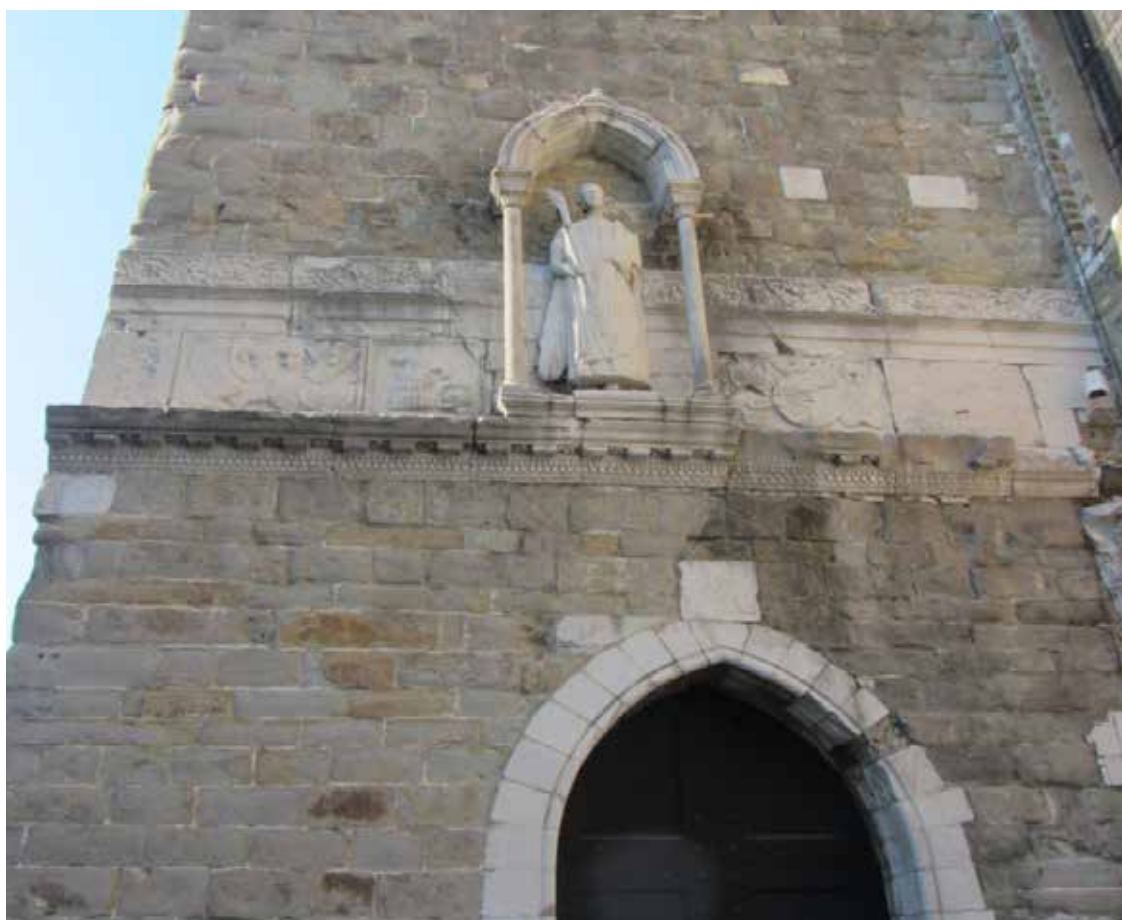
19. Rilievi con fregi d'armi pertinenti al propileo inglobati nella torre campanaria costruita nel corso del '300.
