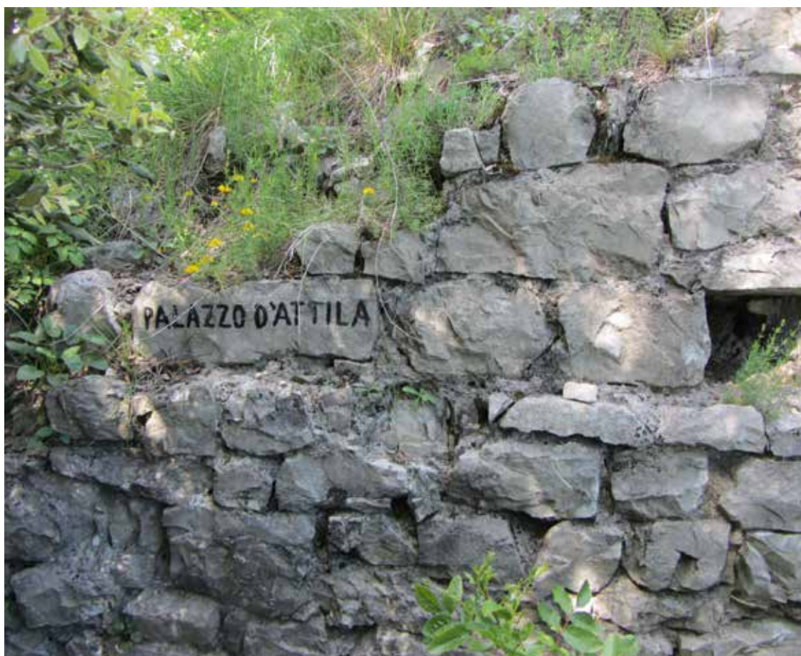
8. Particolare della sostruzioni della villa su cui è indicata la denominazione Palazzo d'Attila.
