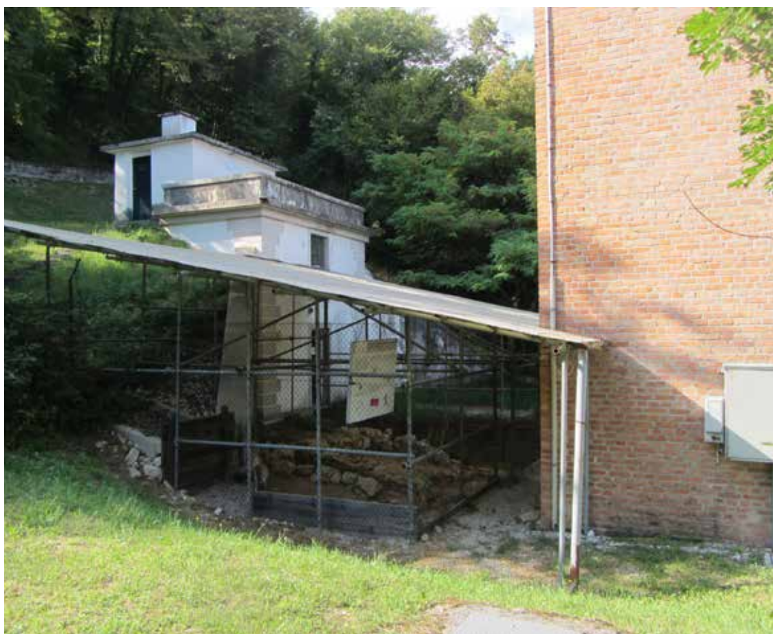
6. L'area di proprietà demaniale della Casa dell'acquedotto. In primo piano la struttura in mattoni della centralina elettrica in disuso.
