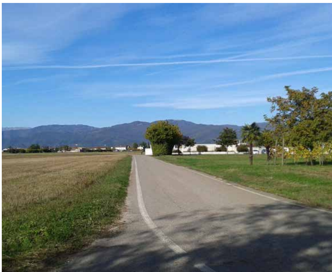
2. La Strada Comunale del Venedrio, di servizio al cimitero di Premariacco, ricalca un cardine.
