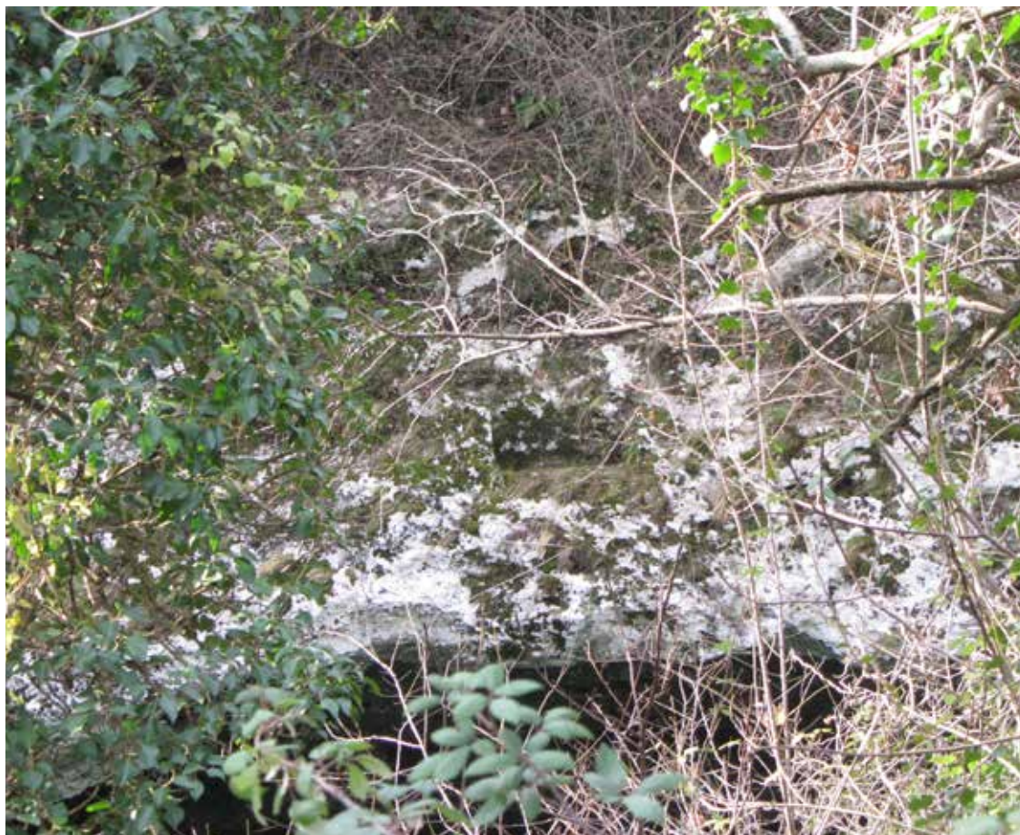
4. Un incasso nella roccia per l'alloggiamento delle strutture di sostegno del ponte romano visibile tra la fitta boscaglia (sponda destra).
