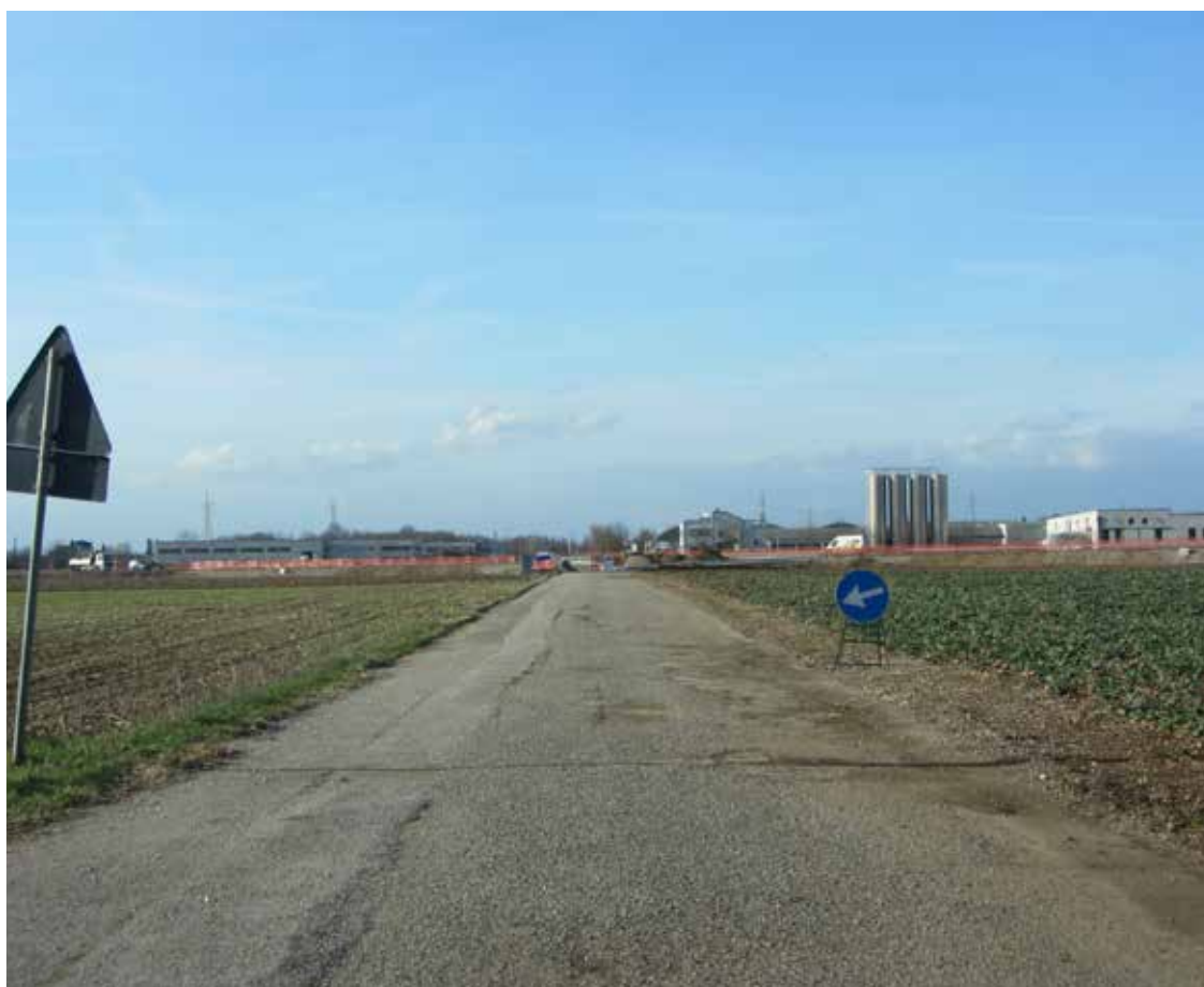
3. San Lorenzo: la strada che perpetua il limite est della centuria è oggetto di lavori per l'inserimento di una rotonda (da sud verso nord). In fondo la zona industriale di Manzano.
