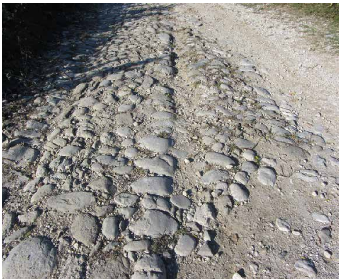
10. La vecchia massiciata della strada che corre lungo la sponda sinistra del Torre.
